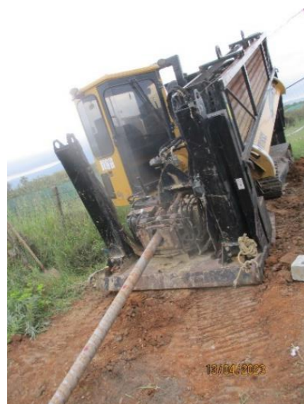
Macchina per infilaggio talpa e tubi sonda
