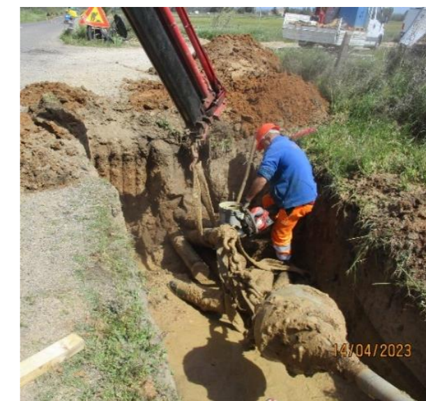
Avvenuto infilaggio dei tubi in PE trascinati dalla fresa
