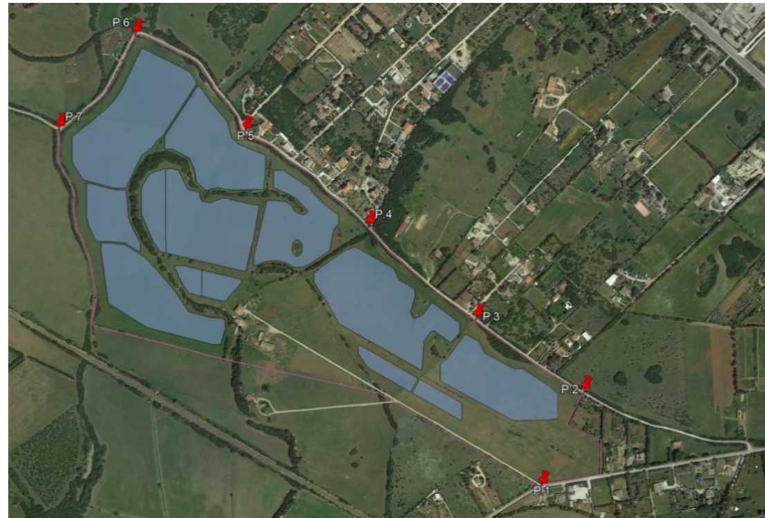
Dettaglio vista da punto di ripresa N.3
