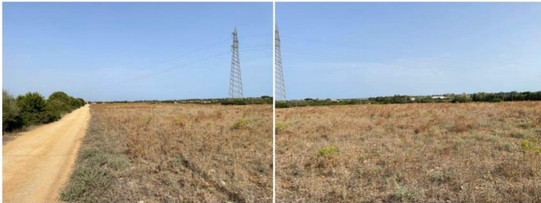
ZSE01 – panoramica con dettaglio linea aerea Terna AAT 150 kV
