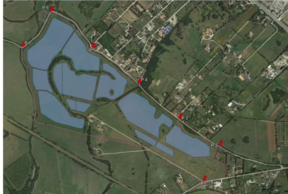
Dettaglio vista da punto di ripresa N.1 da SP 56 – ingresso al predio
