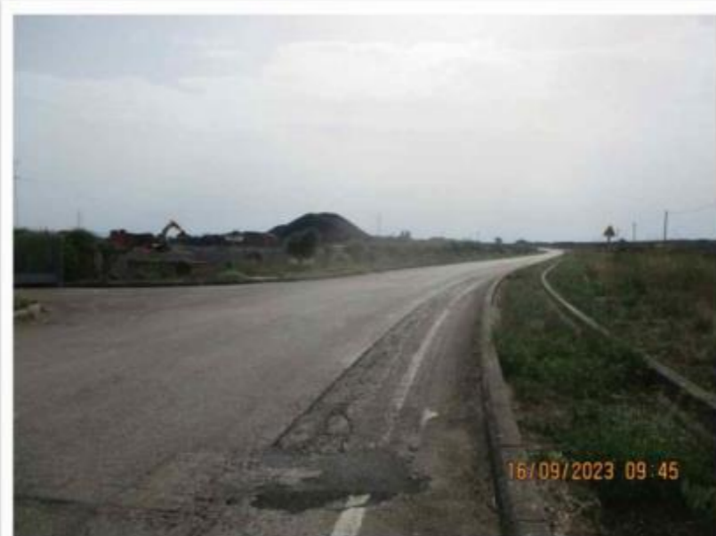
7 BC 16 ATTRAVERSAMENTO LONGITUDINALE CON TOC 1
