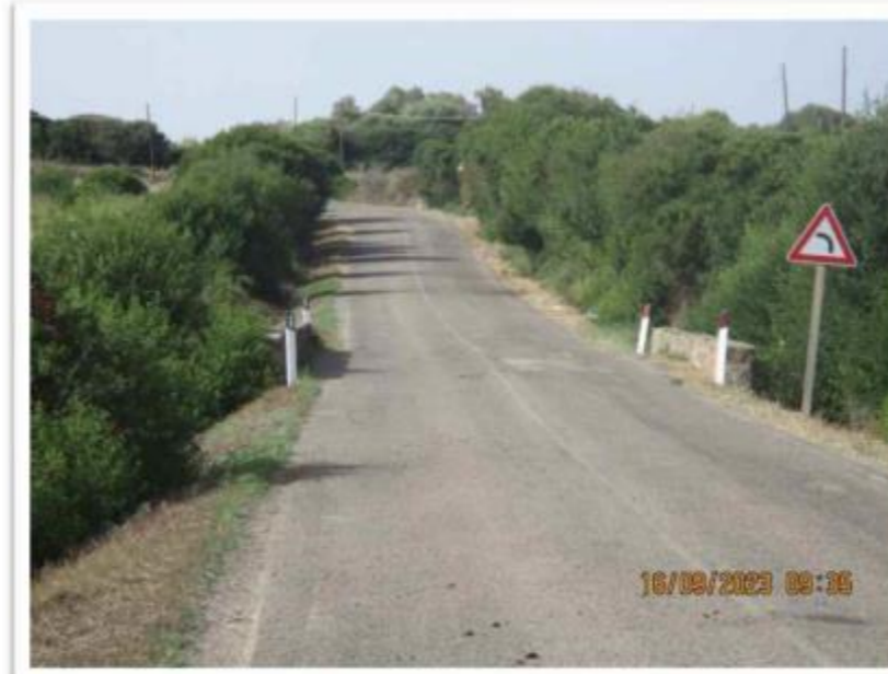
2 BC 12 ATTRAVERSAMENTO LONGITUDINALE CON TOC 1
