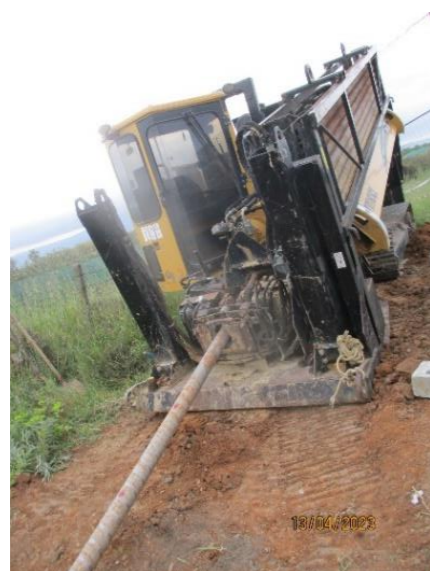
Macchina per infilaggio talpa e tubi sonda
