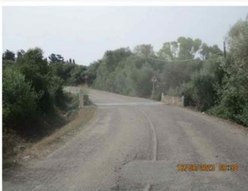
4 BC 14 ATTRAVERSAMENTO LONGITUDINALE CON TOC 1
