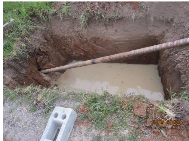
Scavo in prossimità della macchina e tubo sonda
