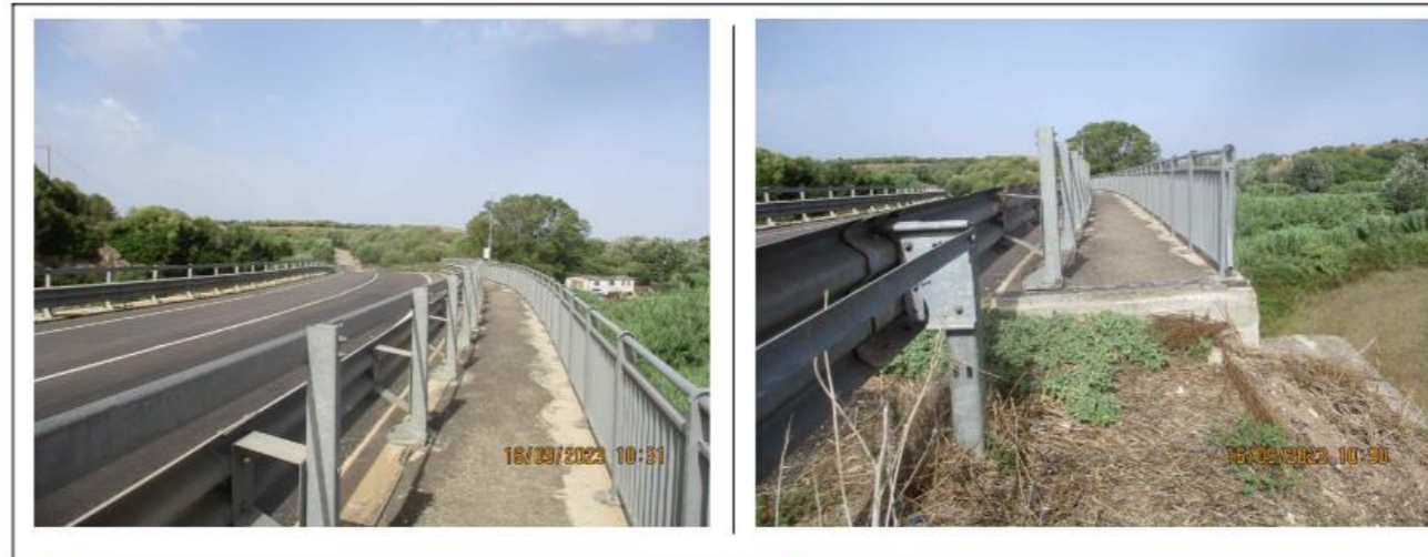
FOTO 01. Particolare del Punto di Attraversamento
