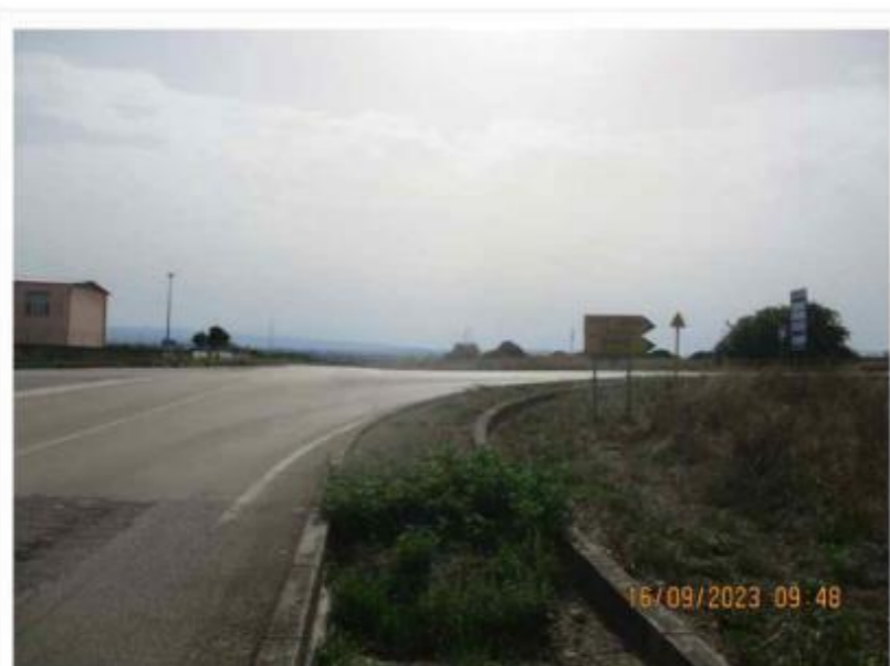
9 BC 19 ATTRAVERSAMENTO LONGITUDINALE CON TOC 1
