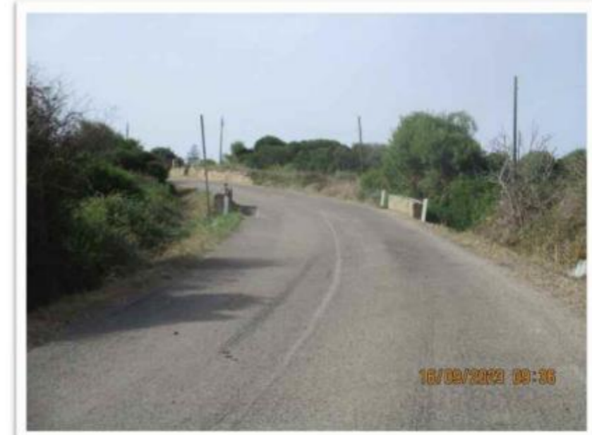
3 BC 13 ATTRAVERSAMENTO LONGITUDINALE CON TOC 1
