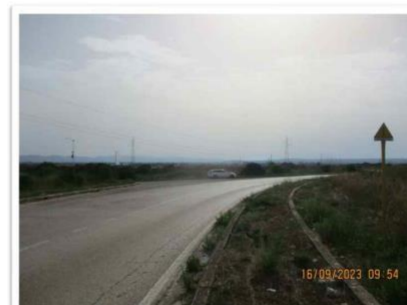
11 BC 111 ATTRAVERSAMENTO LONGITUDINALE CON TOC 1
