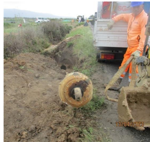
Fresa da 50 cm per la preparazione del foro ove posare il fascio dei tubi di PE
