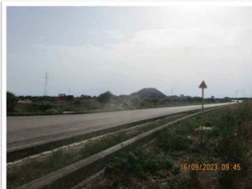
8 BC 18 ATTRAVERSAMENTO LONGITUDINALE CON TOC 1
