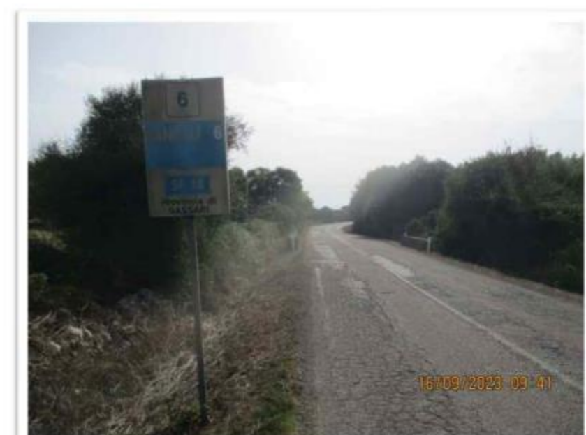
6 BC 15 ATTRAVERSAMENTO LONGITUDINALE CON TOC 1
