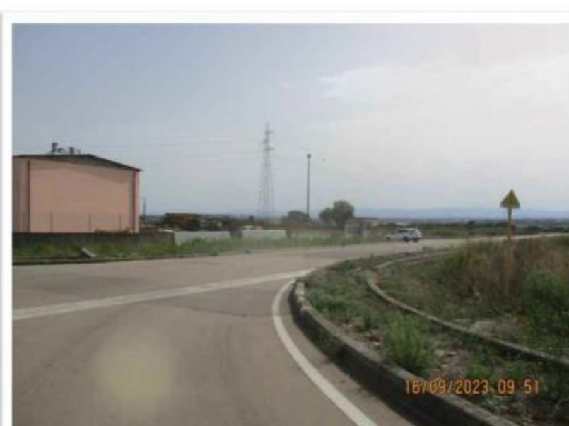
10 BC 110 ATTRAVERSAMENTO LONGITUDINALE CON TOC 1
