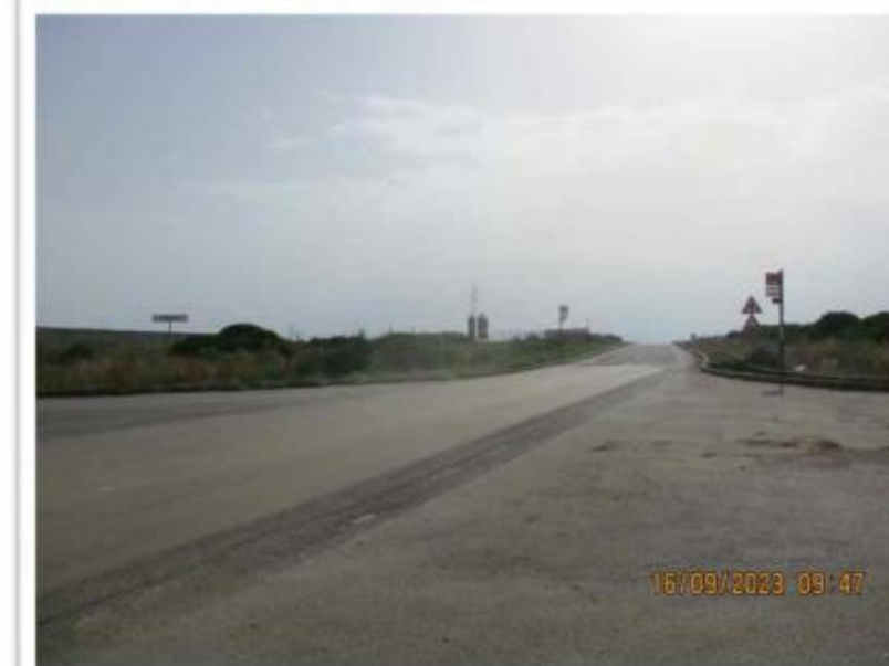
8bis BC 18 ATTRAVERSAMENTO LONGITUDINALE CON TOC 1
