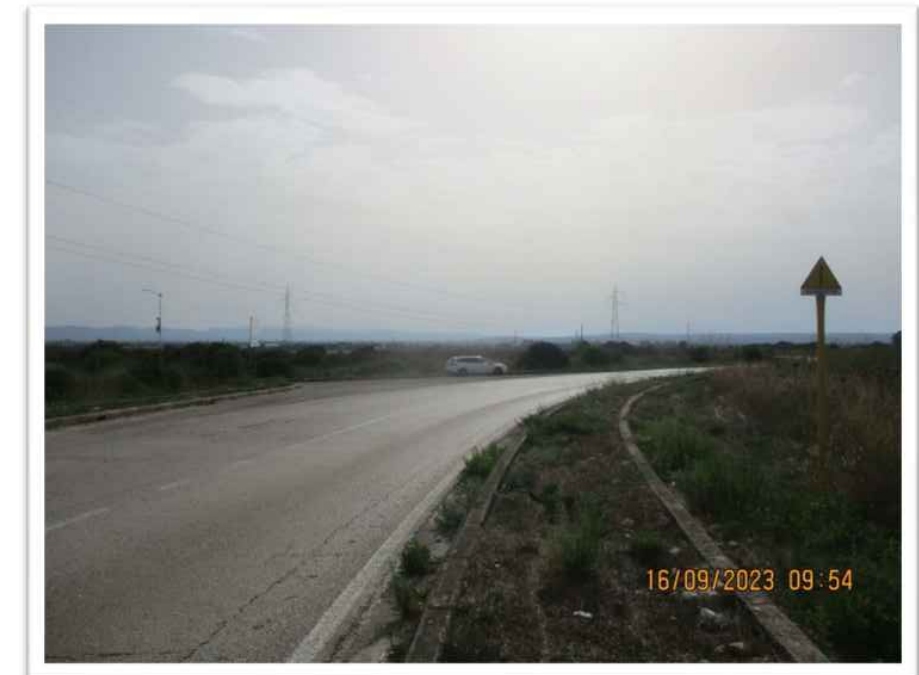
11 BC 111 ATTRAVERSAMENTO LONGITUDINALE CON TOC 1
