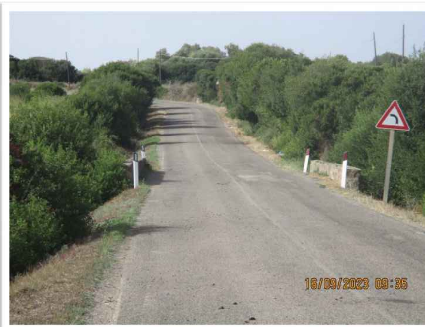
2 BC 12 ATTRAVERSAMENTO LONGITUDINALE CON TOC 1
