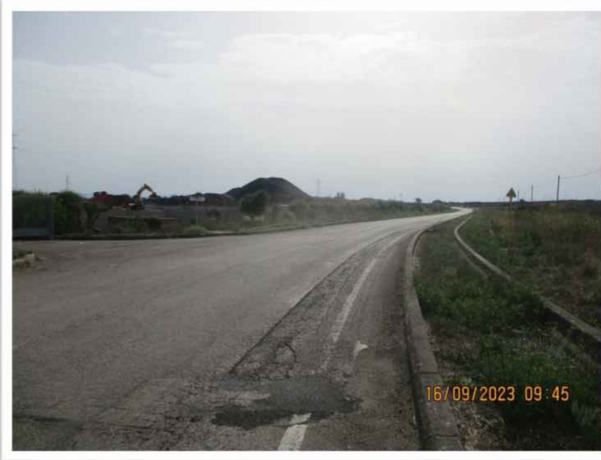
7 BC 16 ATTRAVERSAMENTO LONGITUDINALE CON TOC 1
