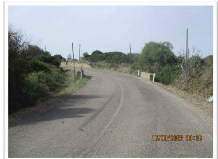
3 BC 13 ATTRAVERSAMENTO LONGITUDINALE CON TOC 1
