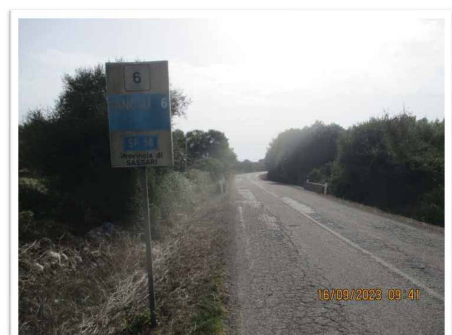
6 BC 15 ATTRAVERSAMENTO LONGITUDINALE CON TOC 1
