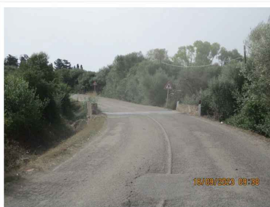
4 BC 14 ATTRAVERSAMENTO LONGITUDINALE CON TOC 1
