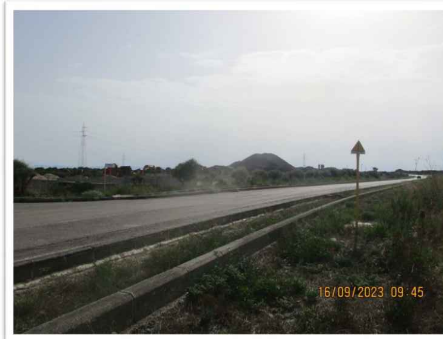
8 BC 18 ATTRAVERSAMENTO LONGITUDINALE CON TOC 1
