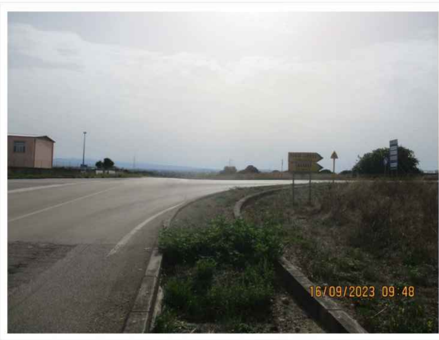
9 BC 19 ATTRAVERSAMENTO LONGITUDINALE CON TOC 1
