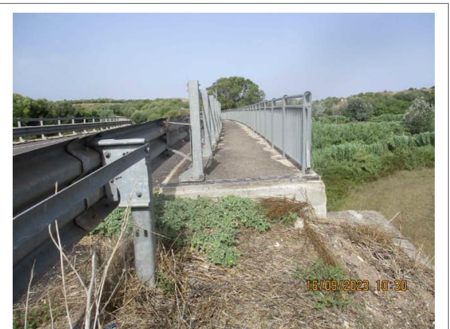
FOTO 02. Inizio dell'impalcato Stradale
