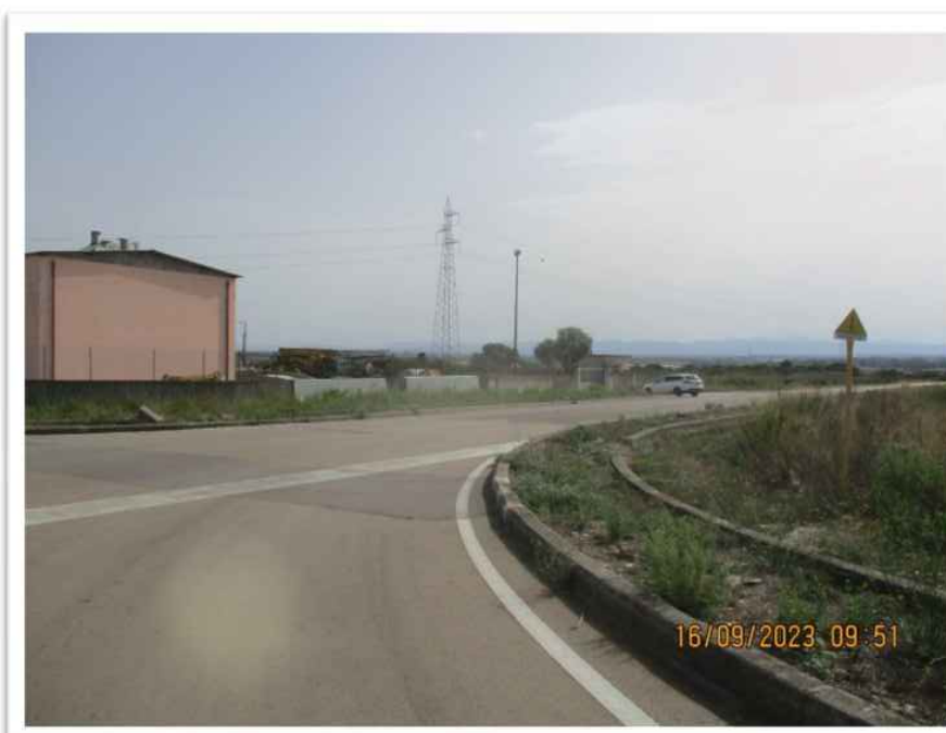
10 BC 110 ATTRAVERSAMENTO LONGITUDINALE CON TOC 1
