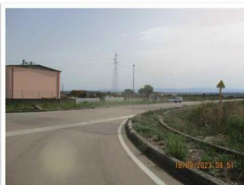
10 BC 110 ATTRAVERSAMENTO LONGITUDINALE CON TOC 1
