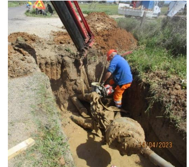
Avvenuto infilaggio dei tubi in PE trascinati dalla fresa
