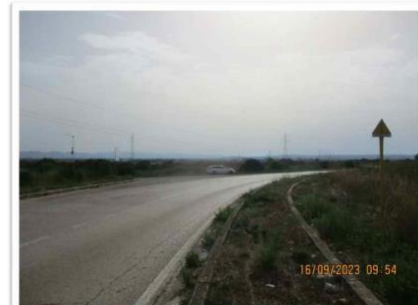
11 BC 111 ATTRAVERSAMENTO LONGITUDINALE CON TOC 1
