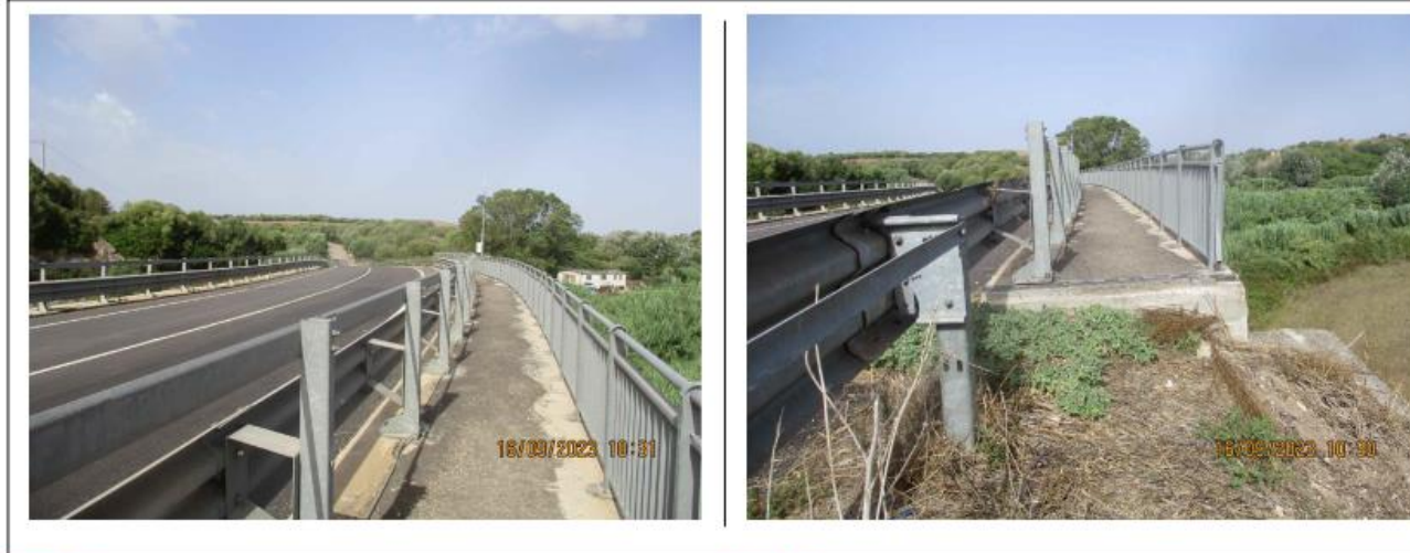
FOTO 01. Particolare del Punto di Attraversamento
