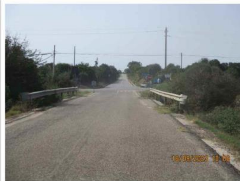
16 BC I15 ATTRAVERSAMENTO CON TOC
