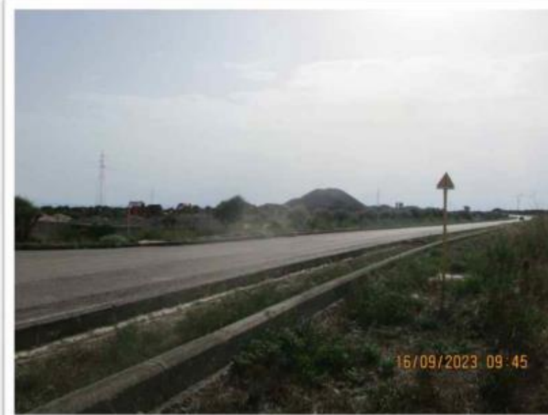
8 BC 18 ATTRAVERSAMENTO LONGITUDINALE CON TOC 1
