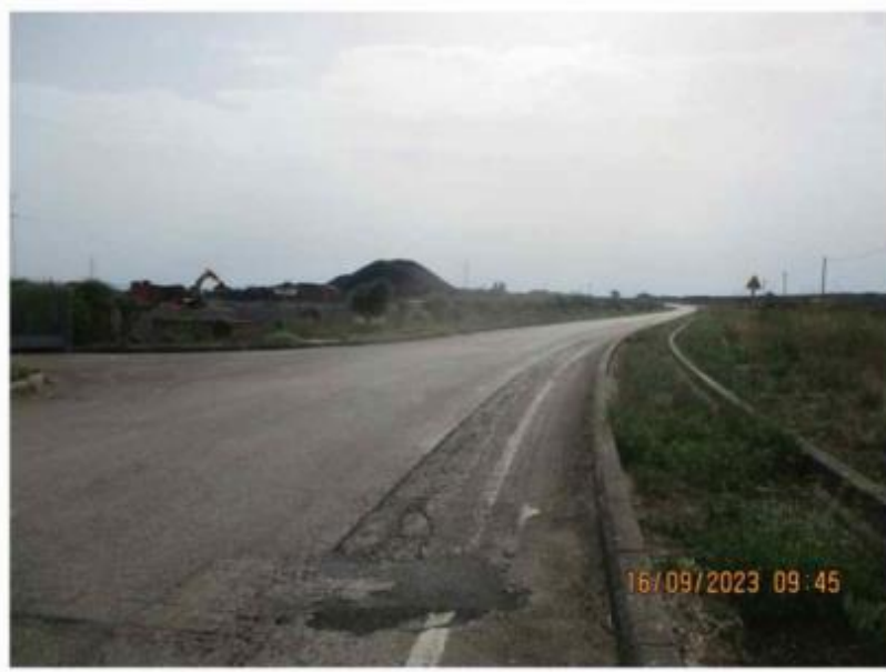
7 BC 16 ATTRAVERSAMENTO LONGITUDINALE CON TOC 1
