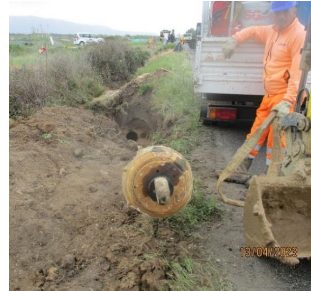
Fresa da 50 cm per la preparazione del foro ove posare il fascio dei tubi di PE
