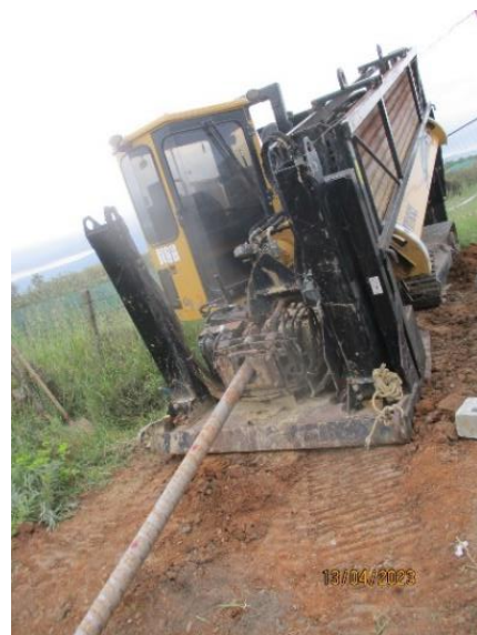
Macchina per infilaggio talpa e tubi sonda
