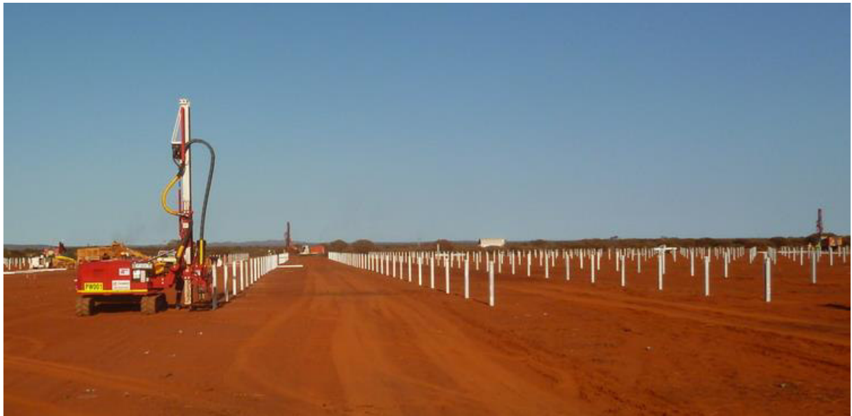
Figura 58: Infissione sostegni a mezzo di battipalo
