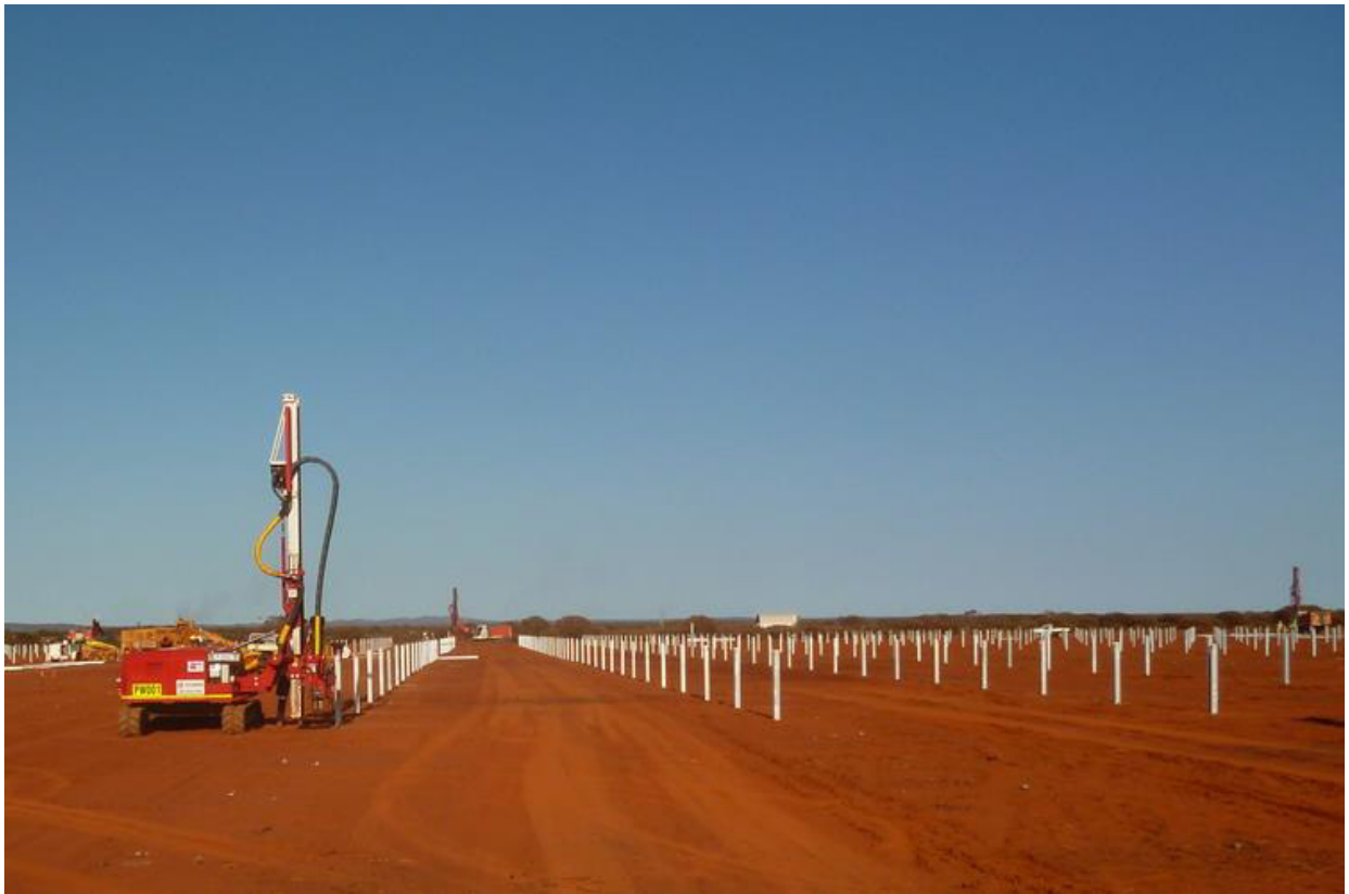
Figura 30: Dettaglio posizionamento pali
