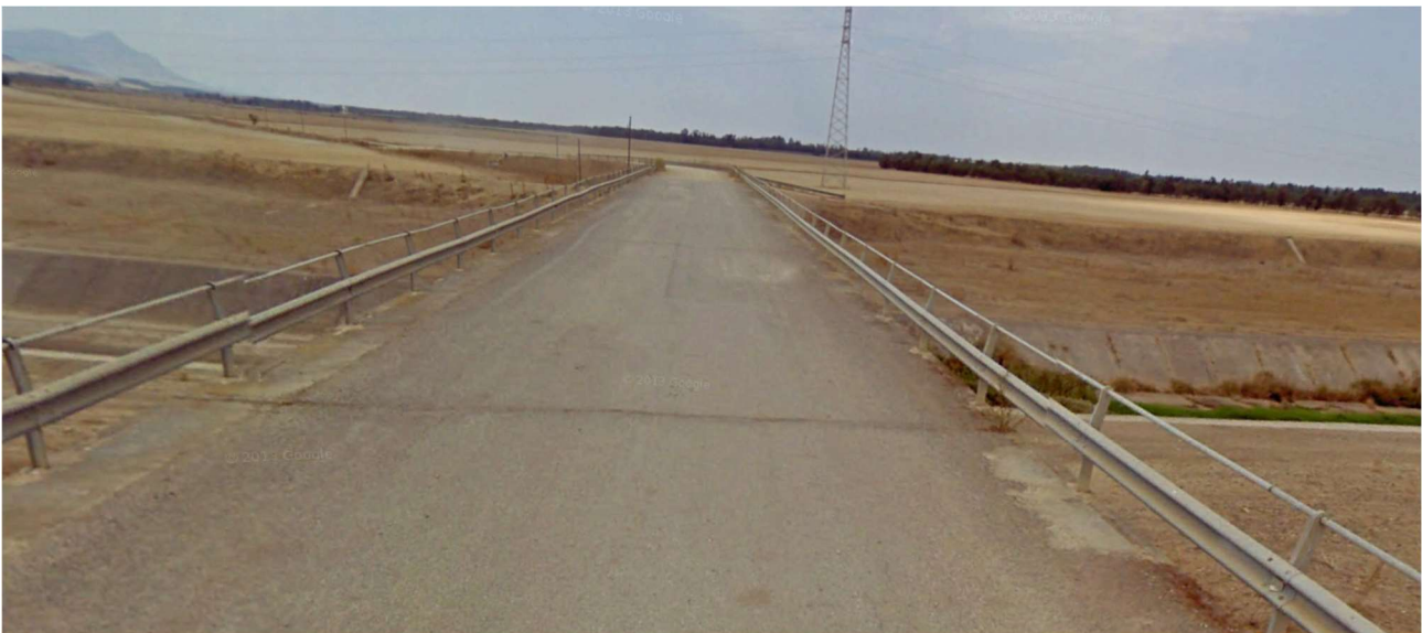
Figura 3 – Attraversamento fossato A
