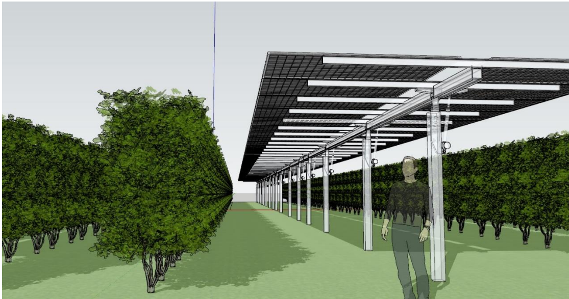
Figura 8 - Immagine impianto, altezza media 2,8 mt
