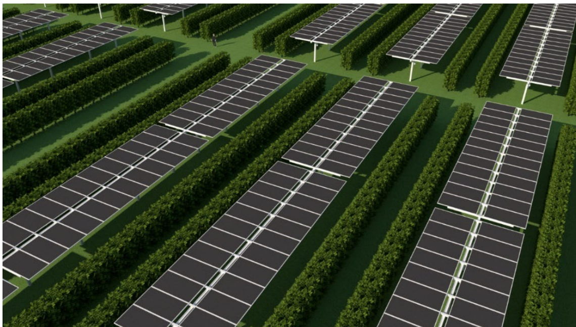
Figura 94 - Particolare del modello, siepi ulivicole e tracker in posizione orizzontale
