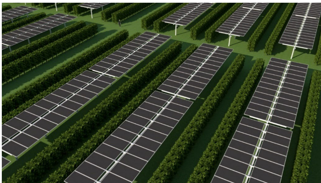
Figura 95 - Particolare del modello, siepi ulivicole e tracker in posizione orizzontale
