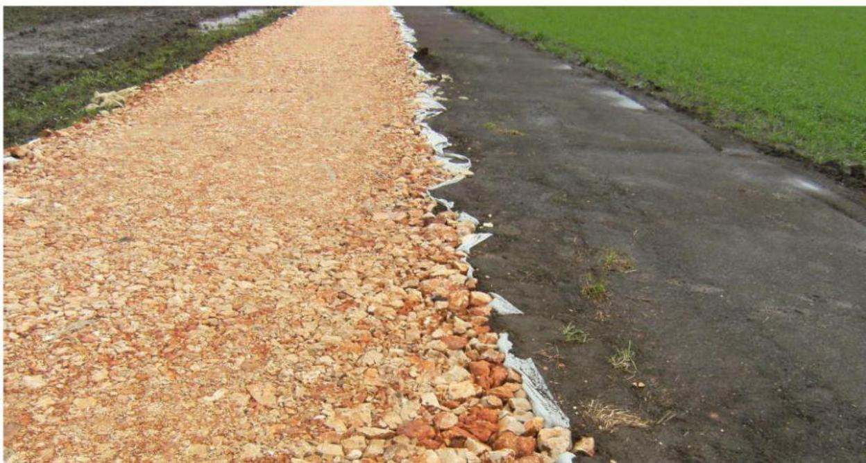
Figura 8-Dettaglio costruzione viabilità interno con terreno stabilizzato
