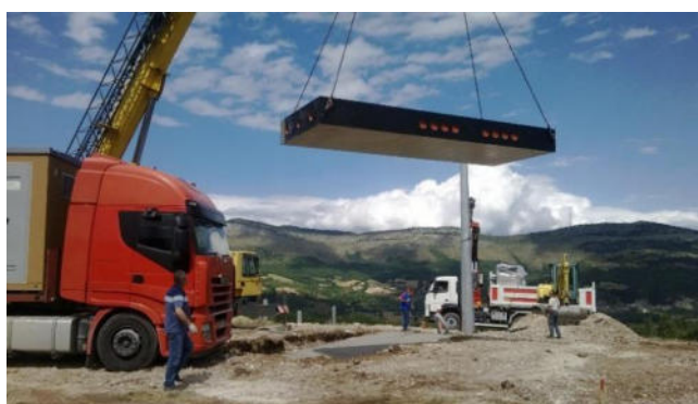
Figura 7: Messa in opera vasca di fondazione
