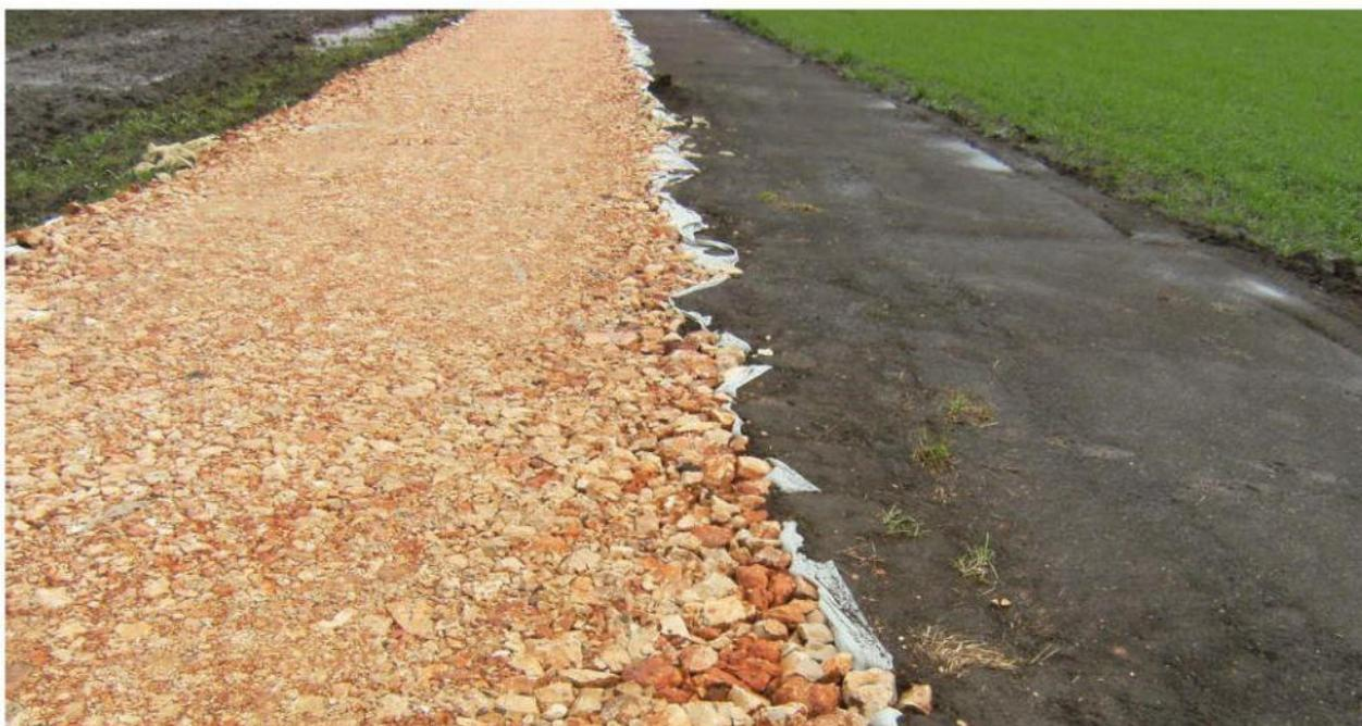
*Figura 28- Dettaglio costruzione viabilità interno con terreno stabilizzato*
