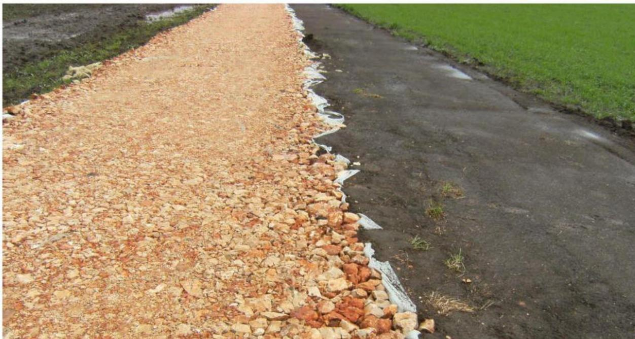
*Figura 26- Dettaglio costruzione viabilità interno con terreno stabilizzato*
