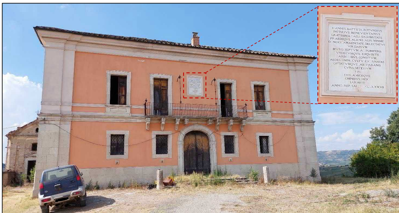
Figura 71: Villa Rotondi - Masseria Mascambroni
