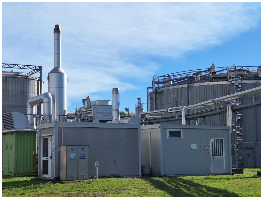
Figura 7.31: Area interno stabilimento dal punto A (vedere Foto 1)
