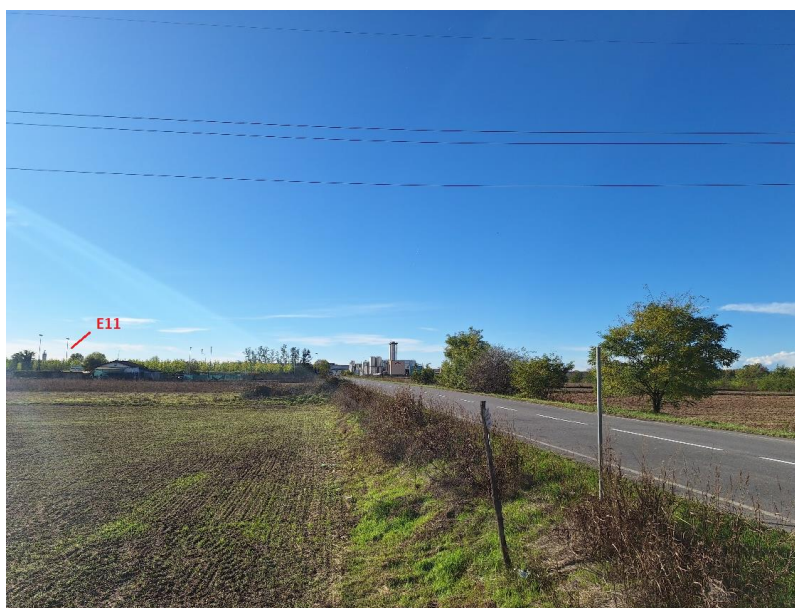
Figura 7.34: Indicazione dell'area trattamento acque di Galbani della attuale dal punto C (vedere Foto 1)
