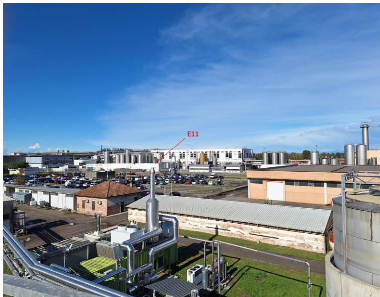
Figura 7.33: Visuale dell'area di intervento verso il punto B (vedere Foto1), con indicazione del punto di emissione del cogeneratore esistente (E11)
