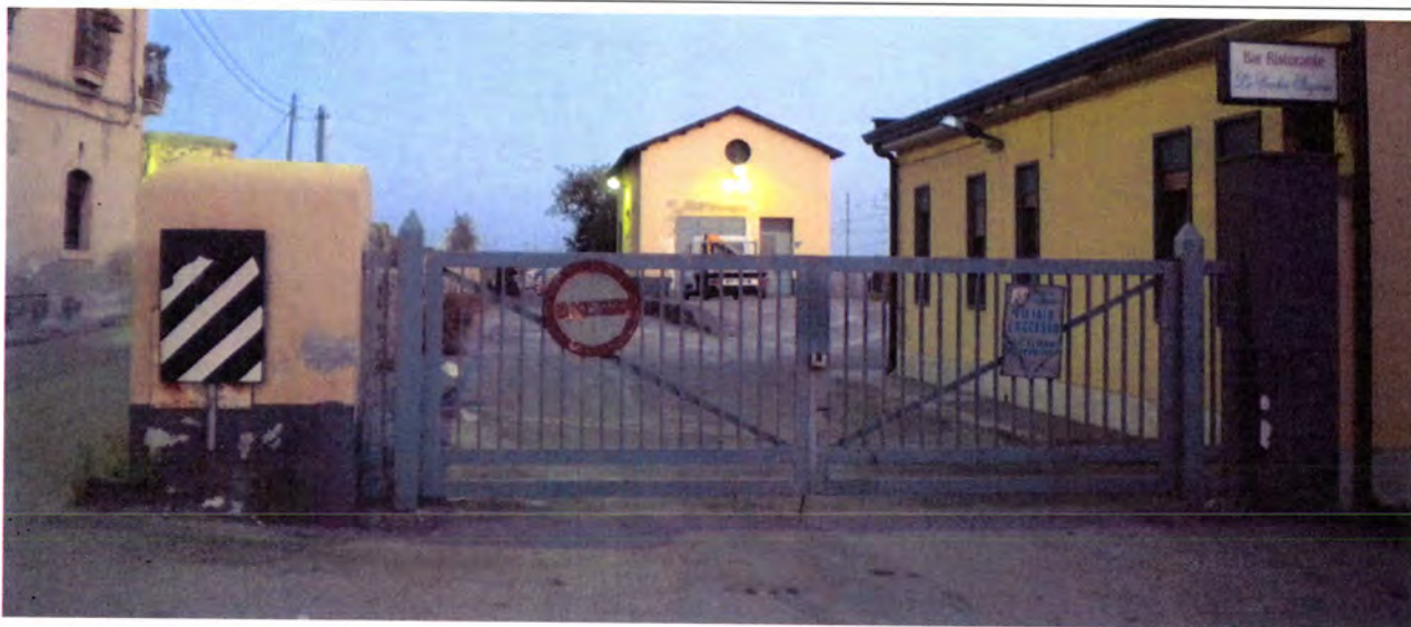
Accesso all'area tramite cancello esistente
