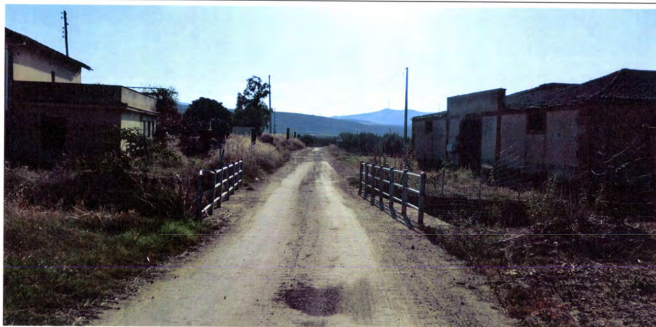
Ponticello lungo la strada poderale di accesso al cantiere, eventualmente da consolidare e adeguare per agevolare il transito dei mezzi di cantiere (approfondimenti che verranno eseguiti nelle successive fasi di progetto)
