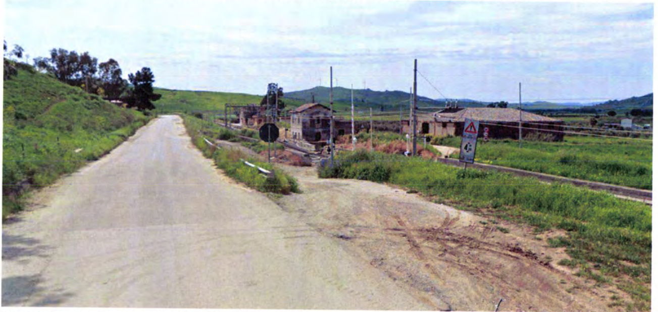
Passaggio a livello esistente in corrispondenza della vecchia Stazione di Libertinia lungo la SS192
