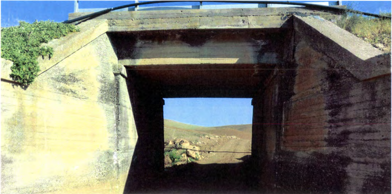
Sottopasso h = 3,00 m L = 3,30 m
