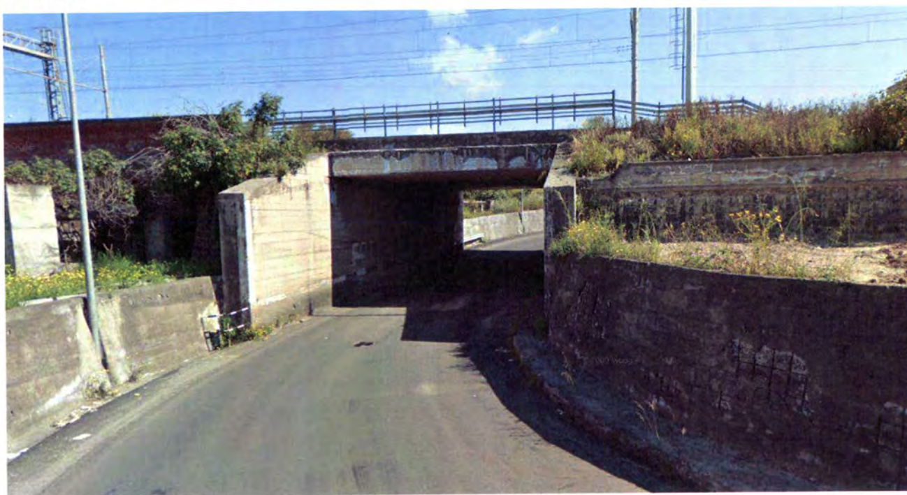
Sottopasso esistente lungo via Catania (altezza maggiore di 4 m)
