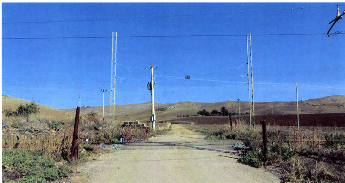
Attraversamento ferroviario privato
