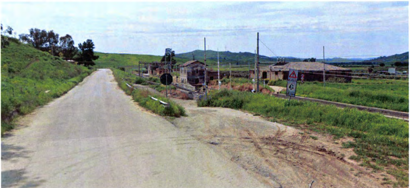
Passaggio a livello esistente in corrispondenza della vecchia Stazione di Libertinia lungo la SS192
