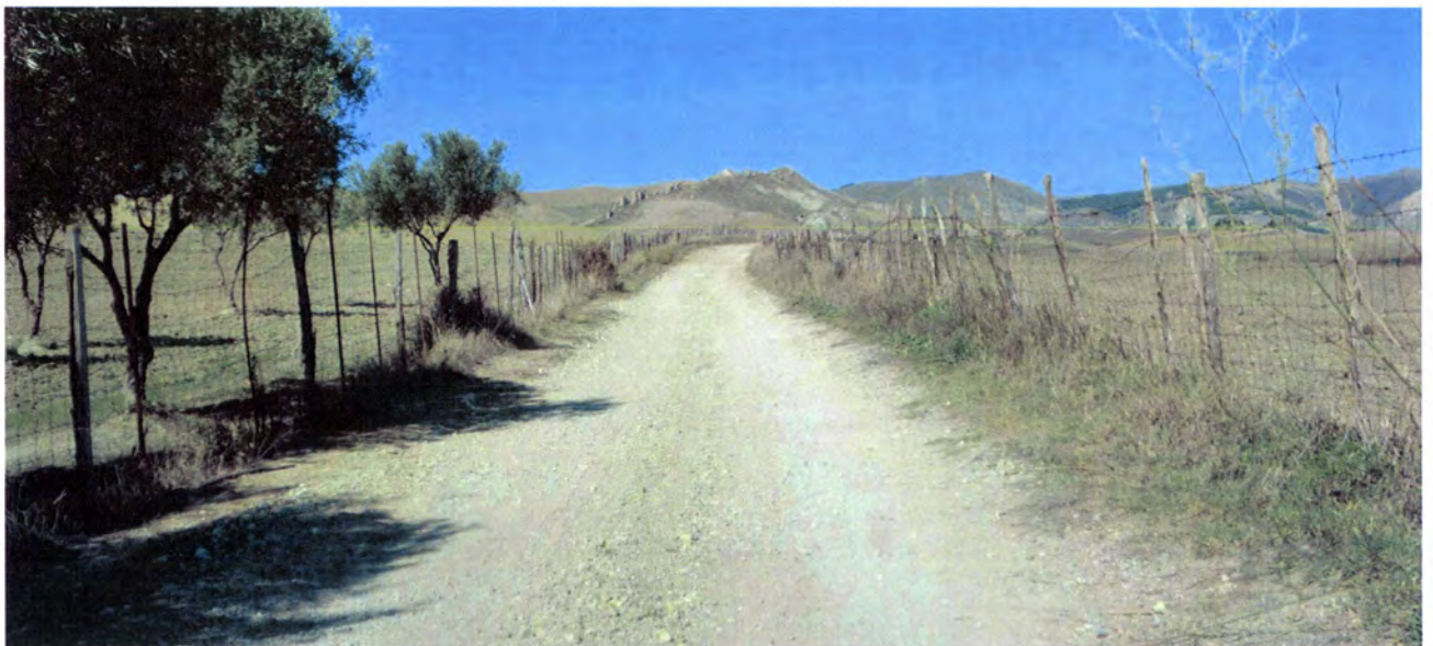
Strada poderale esistente
