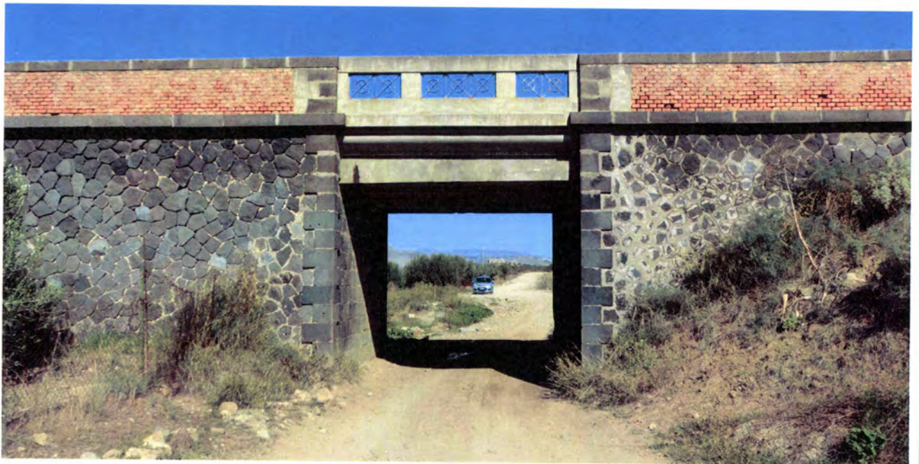
Sottopassaggio esistente con limiti di transito per i mezzi pesanti (h = 3,60 m, L = 4 m)
