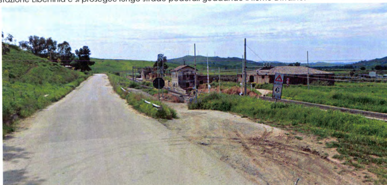
Passaggio a livello esistente in corrispondenza della vecchia Stazione di Libertinia lungo la SS192
