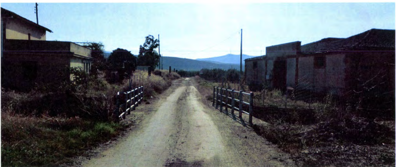
Ponticello lungo la strada podereale di accesso al cantiere, eventualmente da consolidare e adeguare per agevolare il transito dei mezzi di cantiere (secondo gli approfondimenti che saranno fatti nelle successive fasi di progetto)
