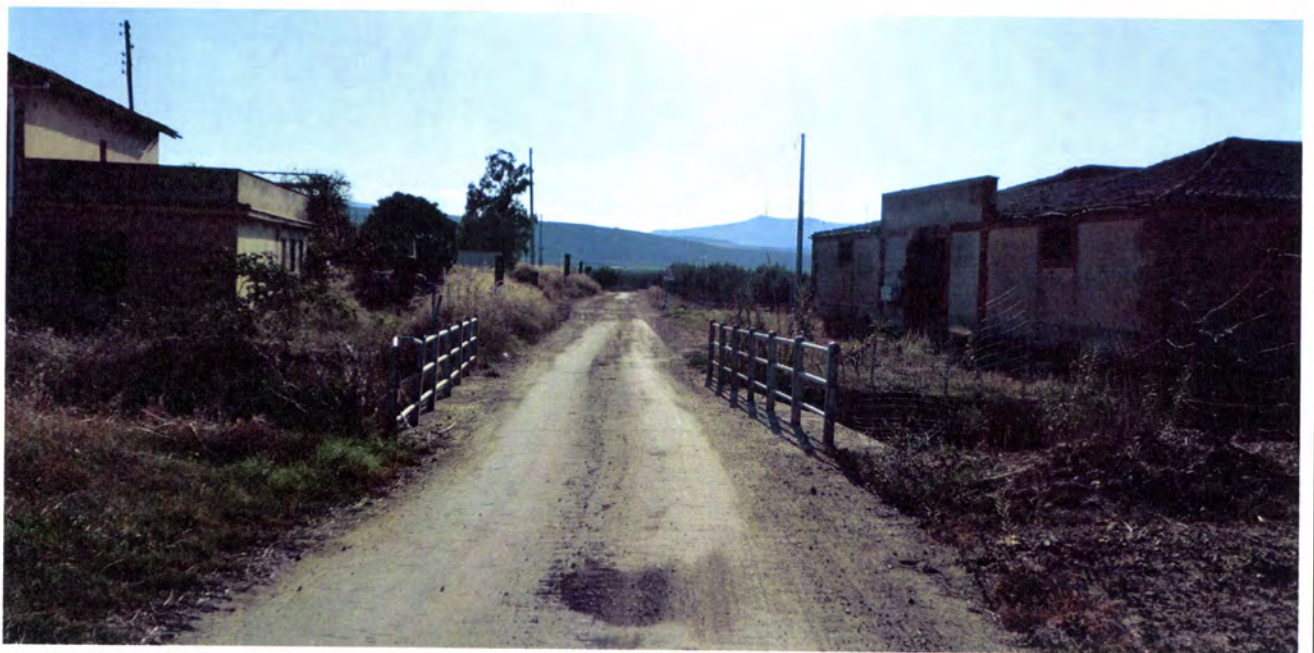
Ponticello da consolidare lungo la strada poderale di accesso al cantiere
