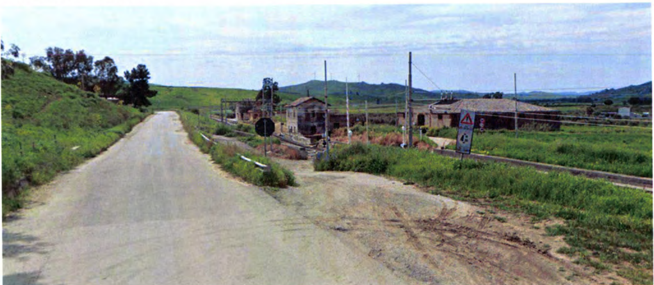
Passaggio a livello esistente in corrispondenza della vecchia Stazione di Libertinia lungo la SS192
