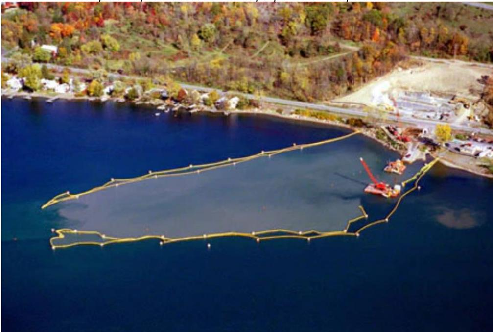
Questi dispositivi sono prodotti in differenti tipologie a seconda di velocità della corrente d'acqua, lunghezza, dimensione della maglia filtrante ecc.
