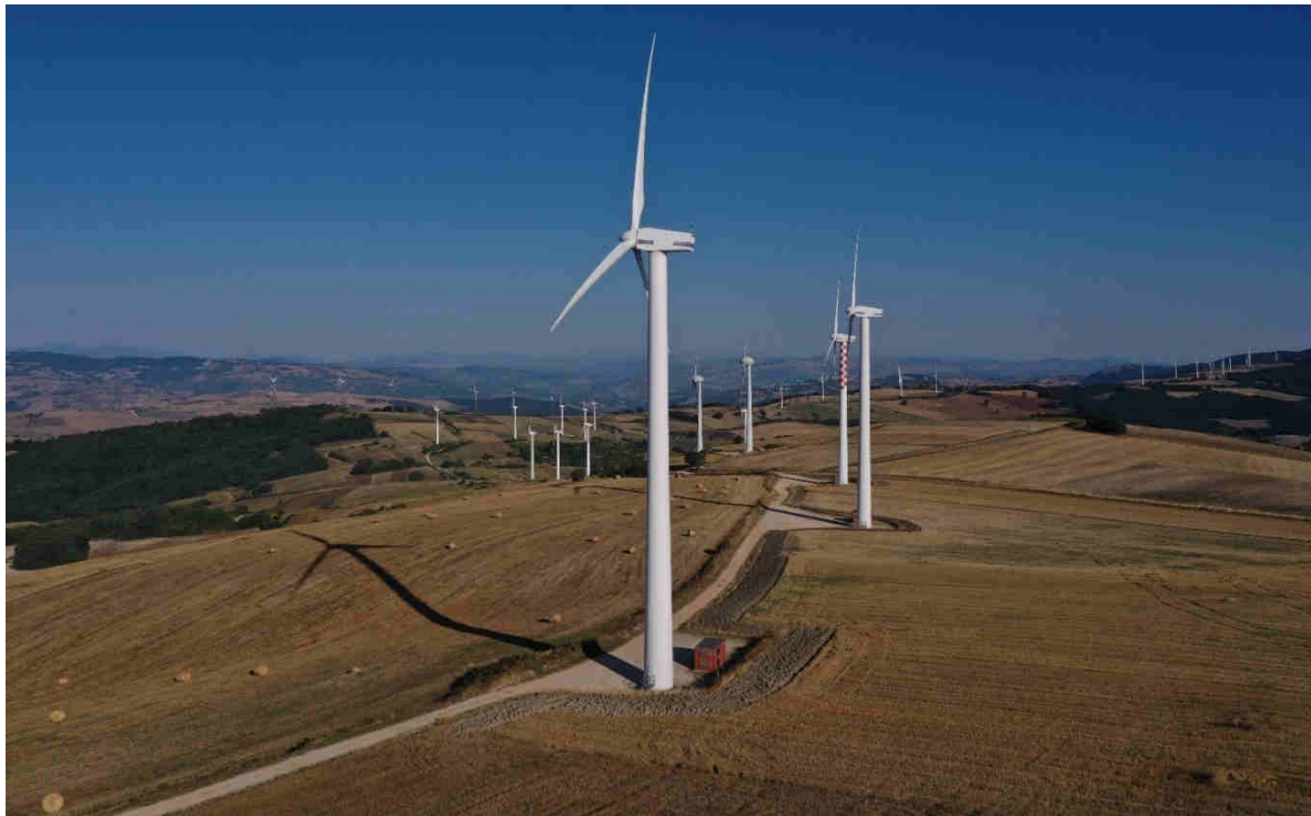
Figura 6. Stato attuale dei luoghi "Impianto A"
