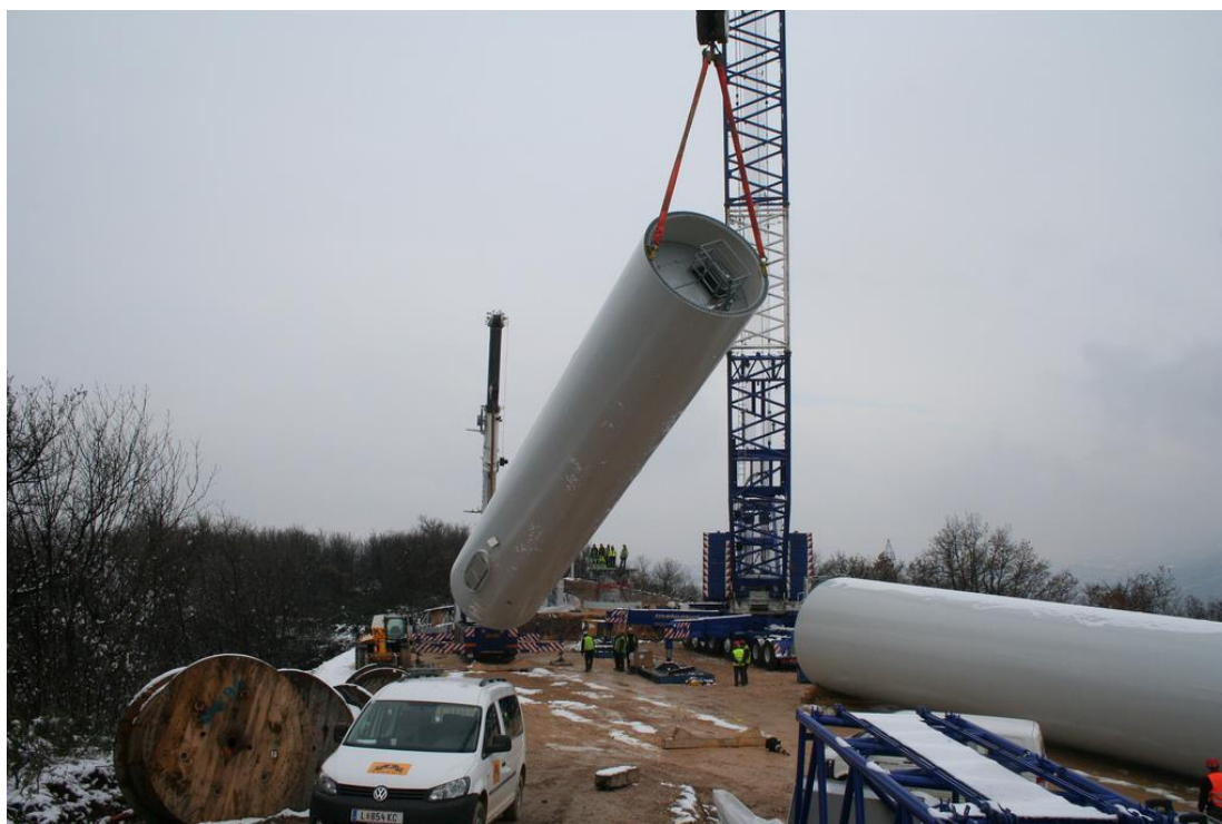
Figura 3. Smontaggio dei tronchi
