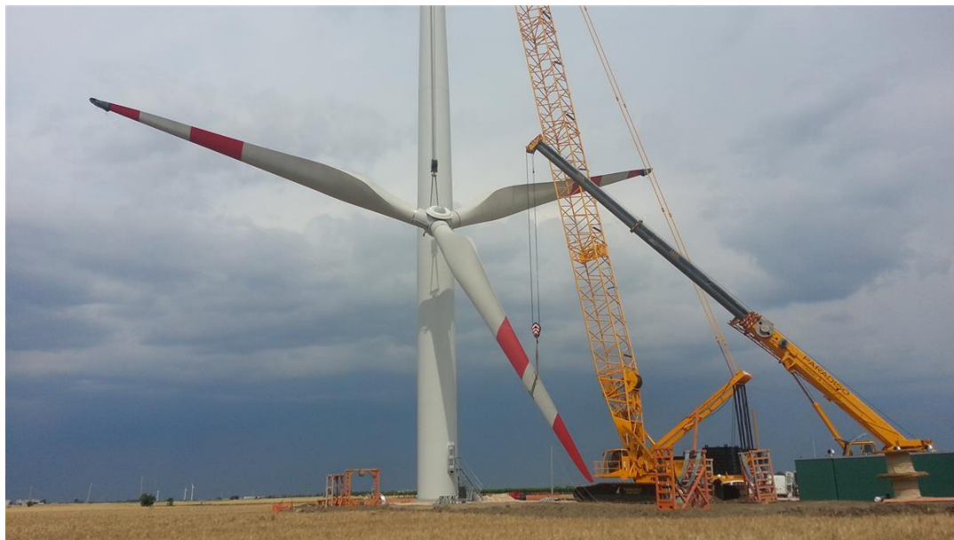
Figura 2. Smontaggio delle pale
