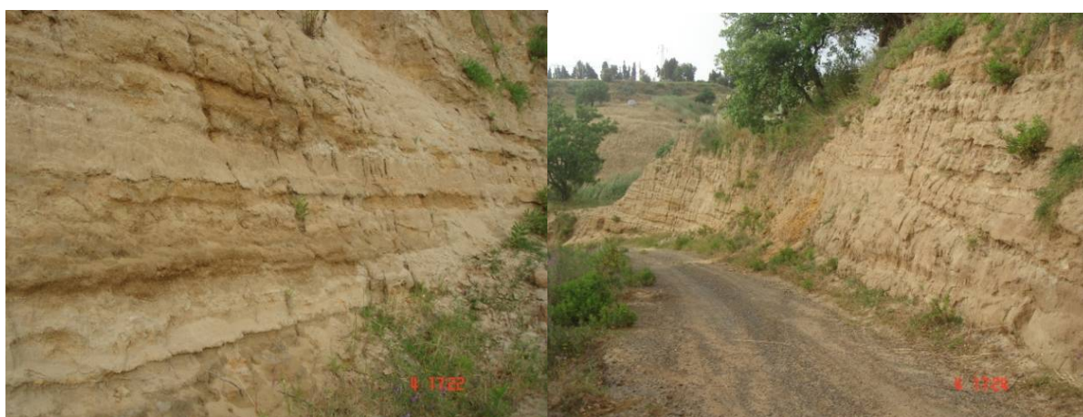
Fig. 3.32 - Pareti di trincea artificiale realizzate nei depositi dei terrazzi marini presso Campo Piaie.
