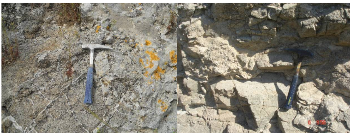
Fig. 3.6 - Affioramento del substrato granitico intensamente fratturato affiorante nel settore meridionale (sinistra) e nord-orientale (destra) dell'area esaminata.
