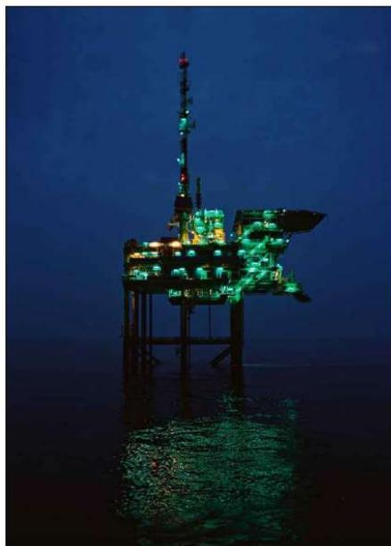
**Figura 5.34** Immagine della piattaforma offshore L15 situata nel Mare del Nord, dopo l'adozione di lampade a basso impatto per gli uccelli. Nel momento dello scatto della foto, alcune lampade bianche non erano ancora state sostituite con quelle verdi. Tratto da Poot et al. (2008).
