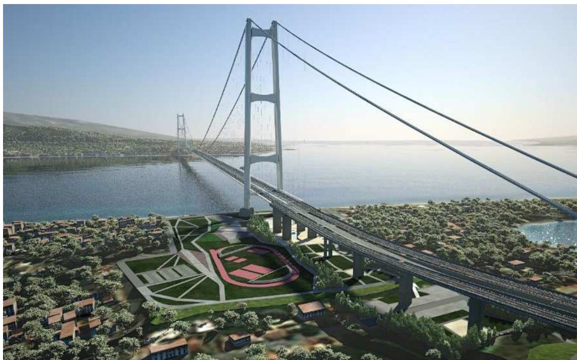
Figura 1.17 - Fotoinserimento del ponte. In primo piano la torre del Versante Sicilia, sullo sfondo il Versante Calabria
