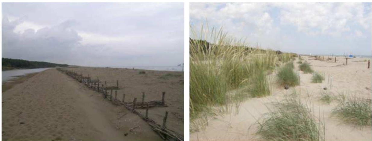
Figura 3.67 – Esempio di realizzazione degli interventi alla Foce del Bevano (RA): la foto di sinistra è del 24 maggio 2006, la foto di destra è del 27 maggio 2009. L'aspetto della copertura vegetale e lo sviluppo raggiunto sono indice della sostenibilità dell'intervento effettuato (Montanari R. (coord), et al., 2009)
