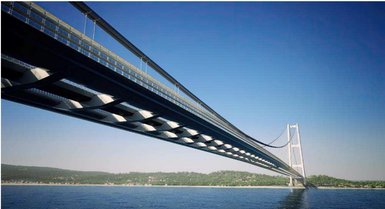
Figura 1.8 - Simulazione prospettica del ponte dalla costa del versante Calabria in direzione della Sicilia, con evidenza della conformazione dell'impalcato
