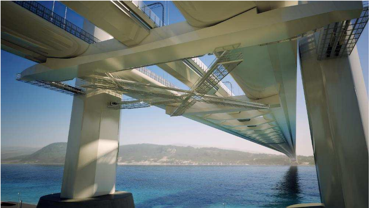
Figura 1.10 - Vista dal basso dell'impalcato in corrispondenza della torre con evidenza dei percorsi per l'ispezione e la manutenzione degli elementi strutturali
