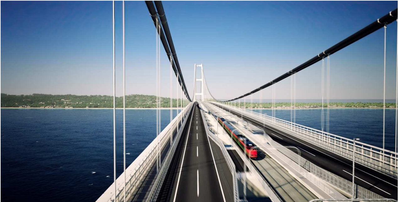
Figura 3.3 - La sezione del nuovo ponte sospeso, esternamente le carreggiate stradali, al centro i binari ferroviari
