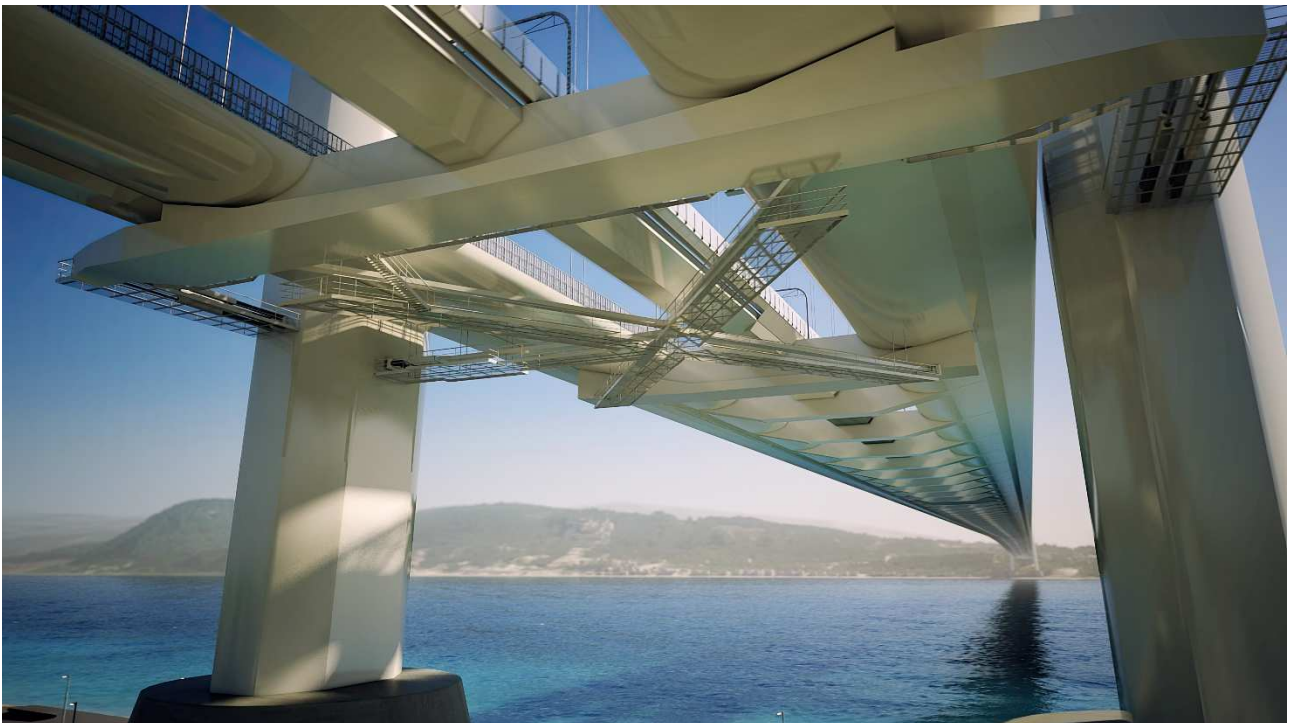
Figura 3.4 - Vista dal basso dell'impalcato in corrispondenza della torre con evidenza dei percorsi per l'ispezione e la manutenzione degli elementi strutturali
