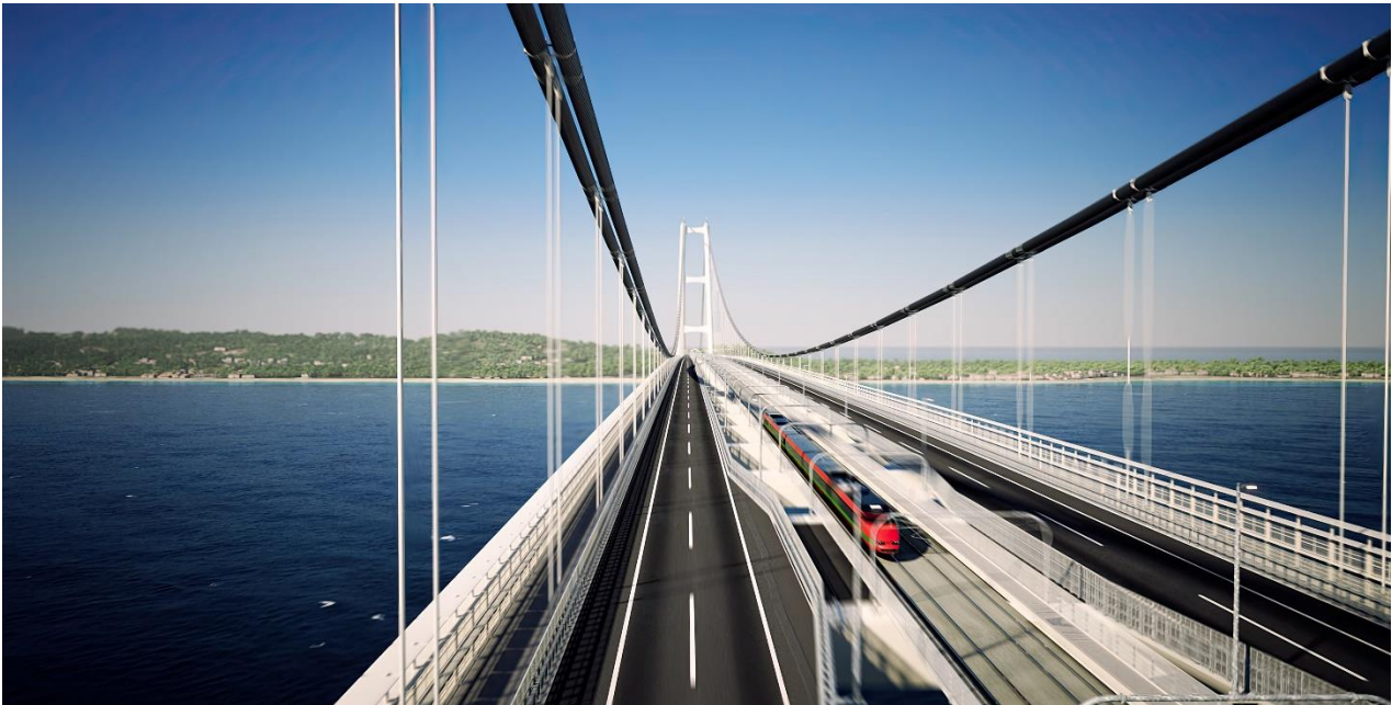
Figura 1-5 La sezione del nuovo ponte sospeso, esternamente le carreggiate stradali, al centro i binari ferroviari
