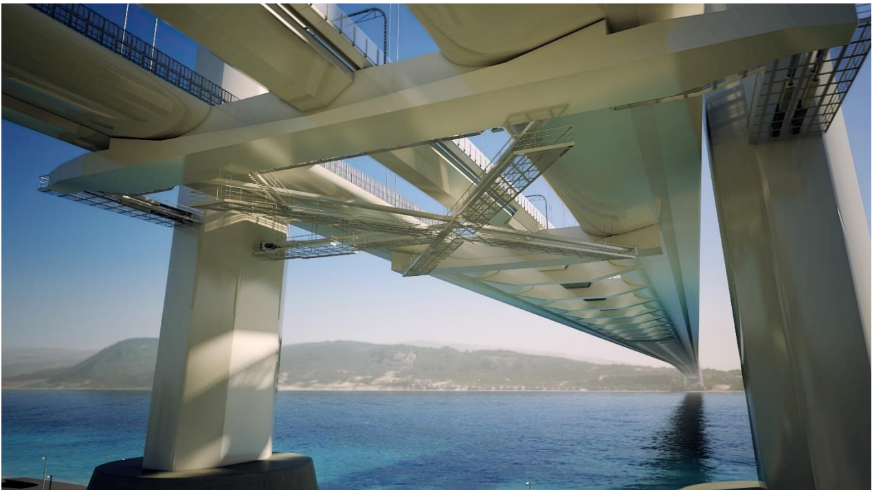
Figura 1-6 Vista dal basso dell'impalcato in corrispondenza della torre con evidenza dei percorsi per l'ispezione e la manutenzione degli elementi strutturali
