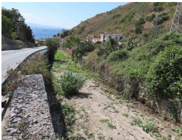
Foto 3-38– Particolare del corso d’acqua in cui si prevedono interventi di miglioramento/ripristino dell’Habitat 3290
