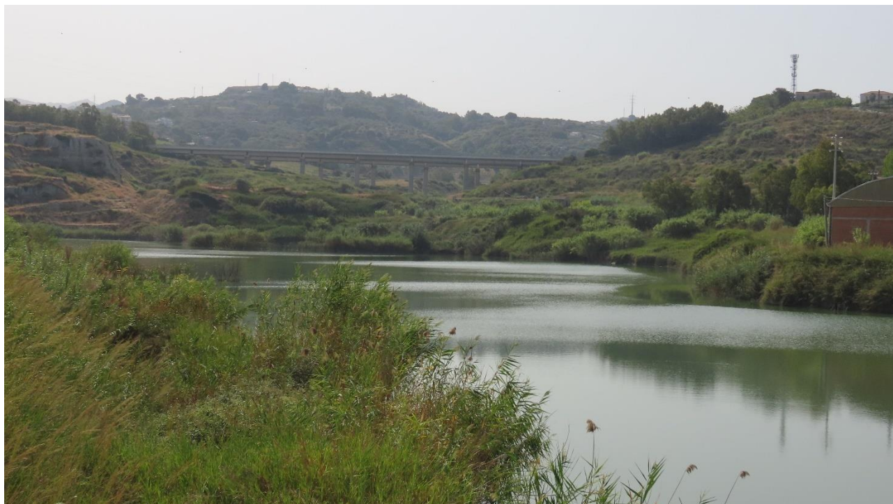
Figura 3-57. Invaso della Cava Spadafora dal lato Nord.
