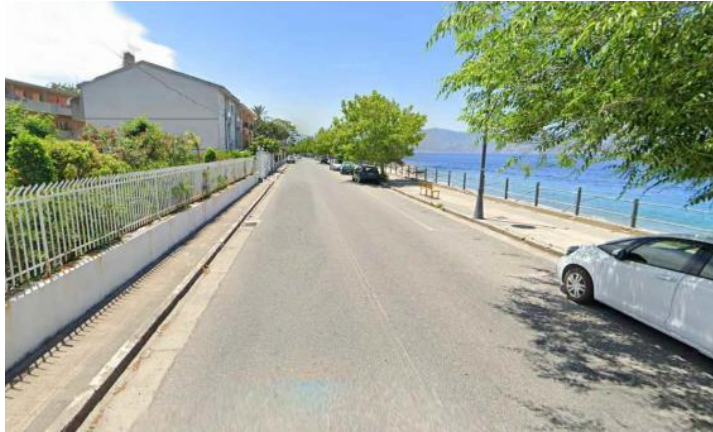
Vista ante operam del lungomare lato Calabria
