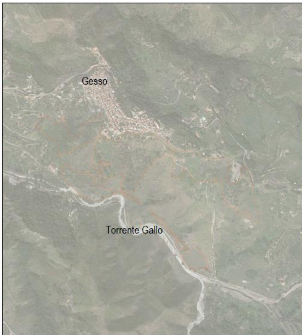
SF15 -Area di riforestazione con vegetazione a supporto della sosta dei passeriformi
