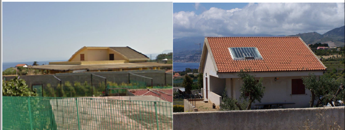
Figura 3.21 Sicilia - Ricettori oggetto di verifica di intervento (735 a sx - 773 a dx)
