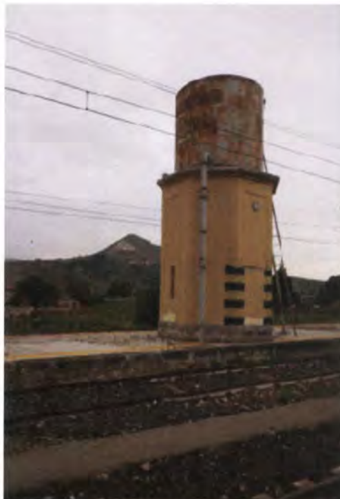
Figura 7-6 - Serbatoio idrico pensile in prossimità della vecchia stazione.
