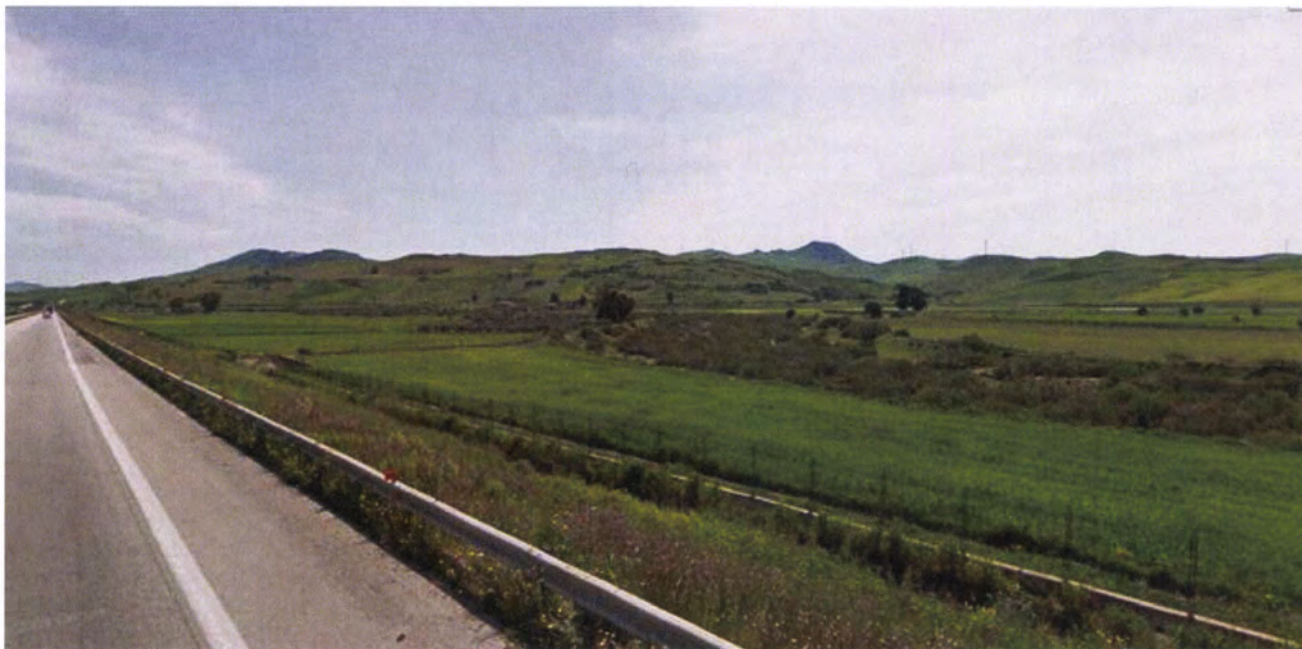
Figura 6-7 - Punto di vista sull'autostrada A19: situazione attuale.
