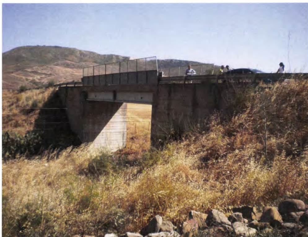
Foto 3. Cavalcaferrovia esistente in prossimità della masseria Zito.
