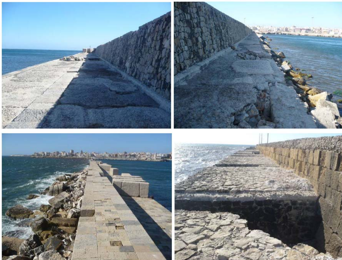
Figura 3.10. – Porto di Marsala. – Molo di sopraflutto. – Situazione attuale.
