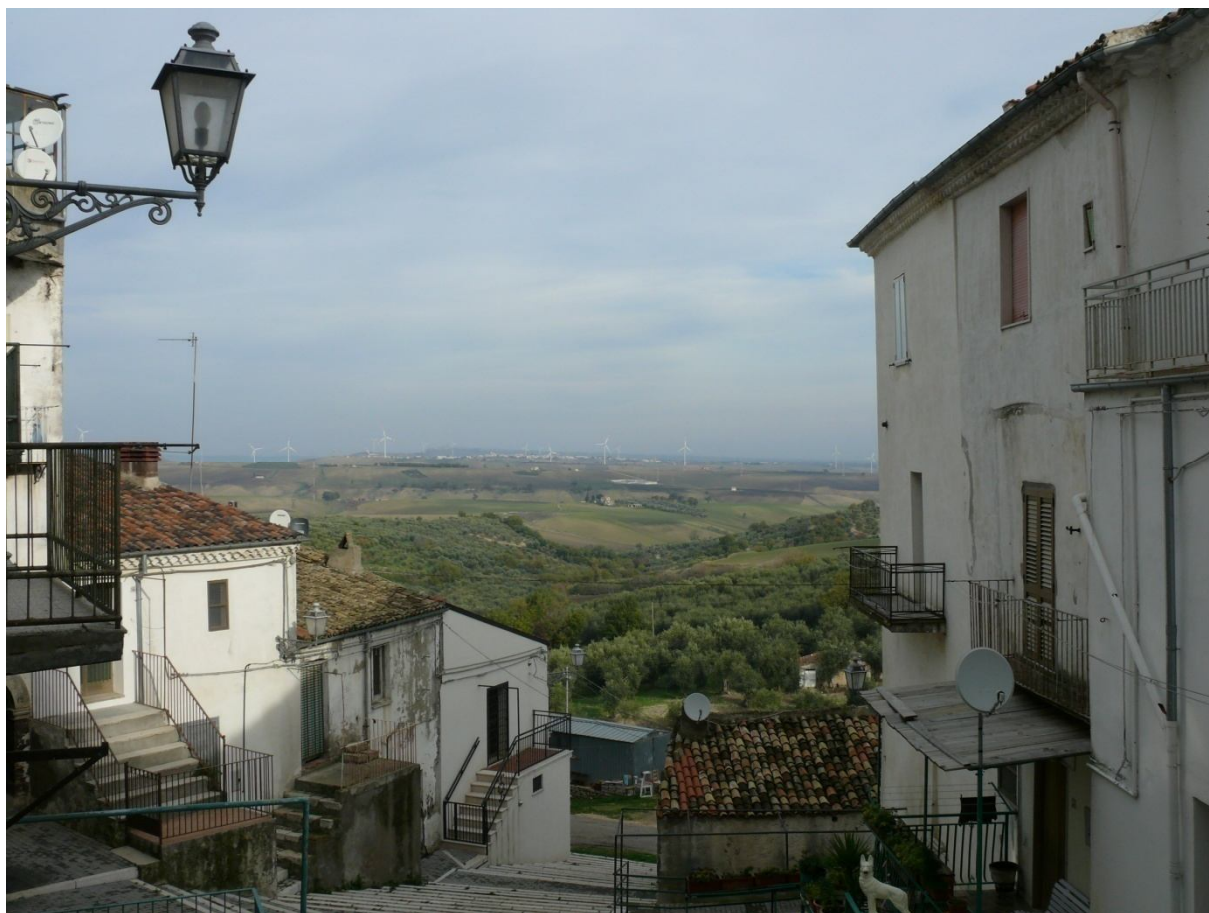
Figura 7.2-2. Punto di vista PV1 post.
