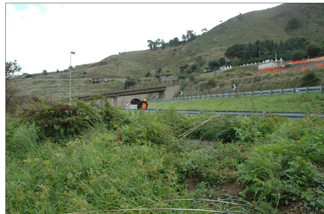
F22 - SVINCOLO S. TRADA
