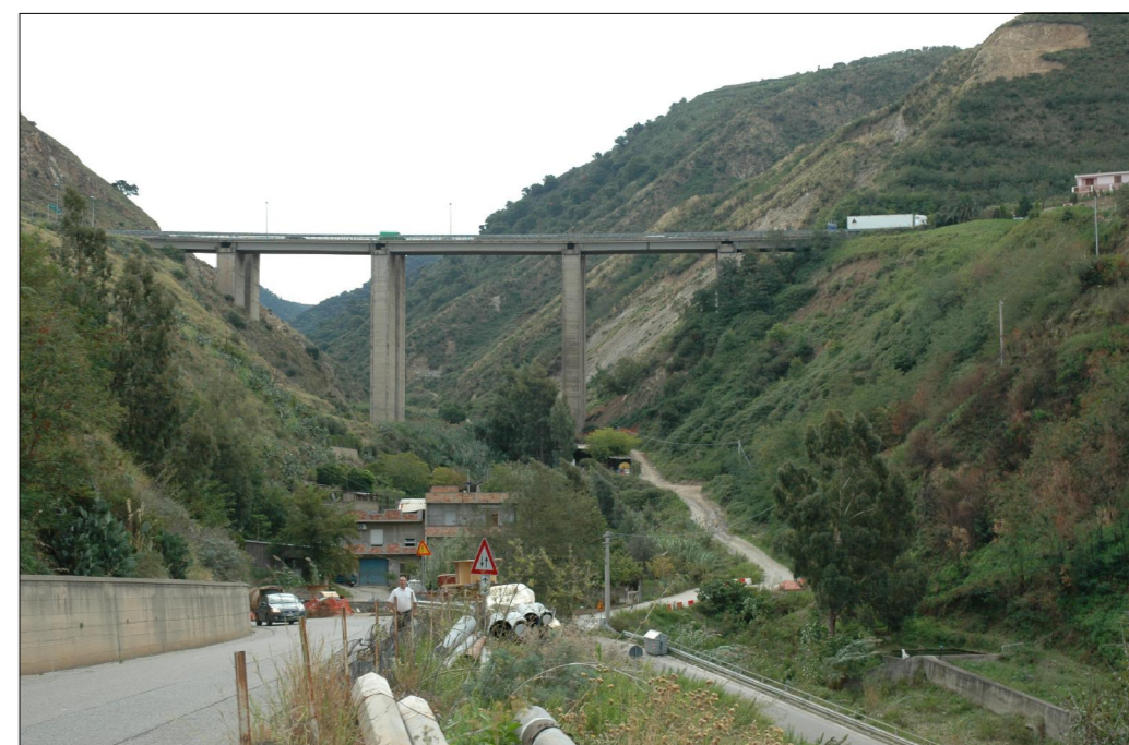
F23 - VIADOTTO S. TRADA
