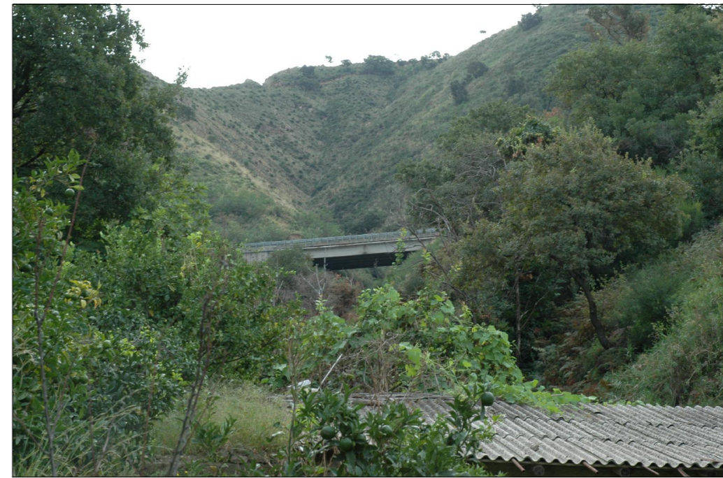
F24 - VIADOTTO PRESTAMI
