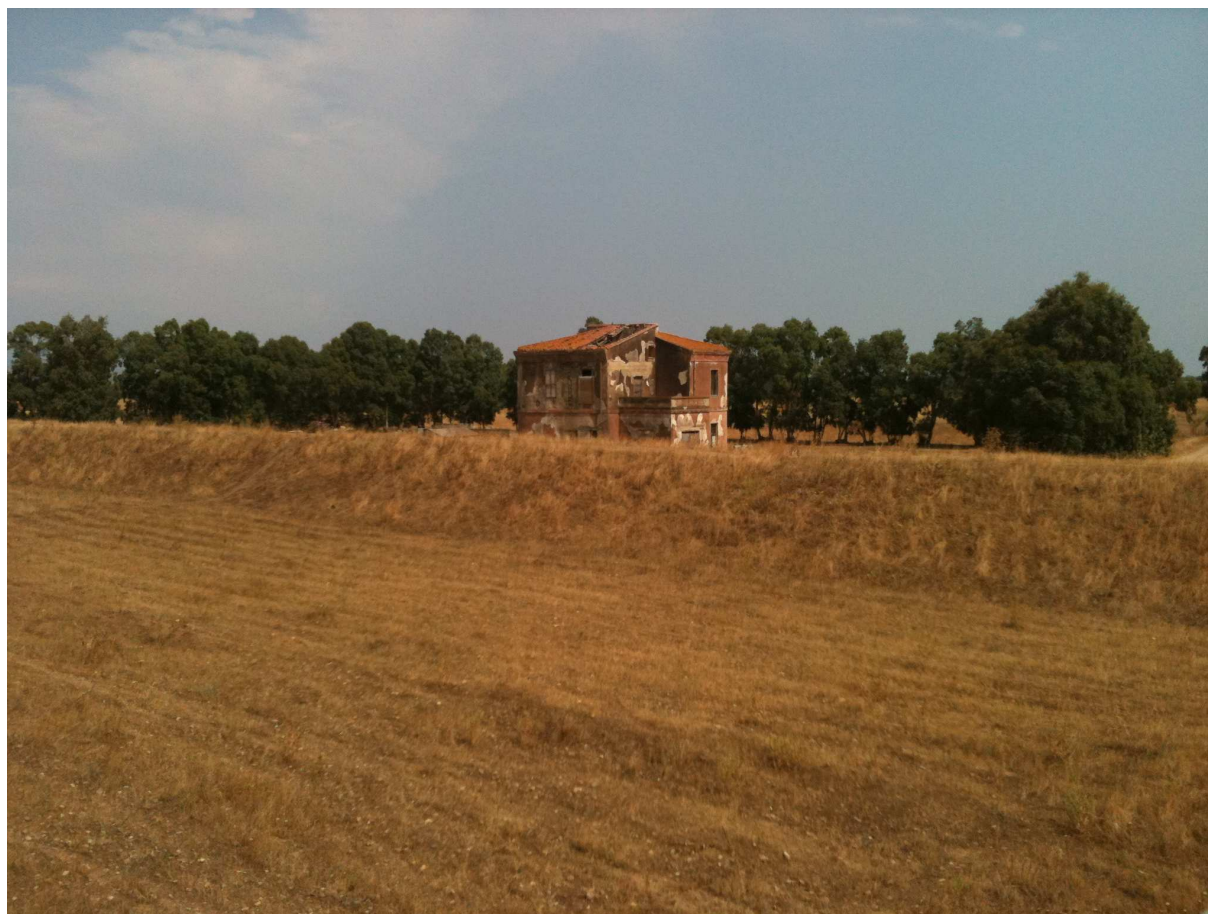
Ricettore n. 8: casa cantoniera in stato di abbandono
