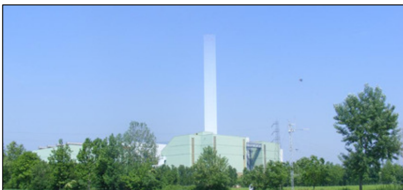
Figura 102: Esempio colorazione camino termovalorizzatore A2A Brescia
