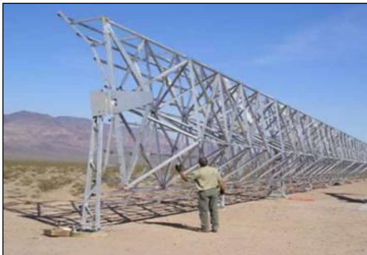
Figura 53: Esempio Struttura SolarGenix Acciona
