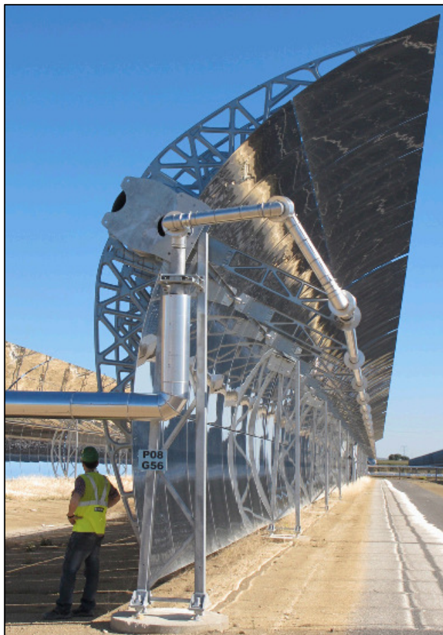
Figura 46: Collettore parabolico lineare SNT2
