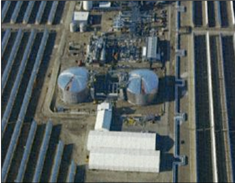
Figura 77: Esempio Power Block in costruzione (Impianto 100 MWe)
