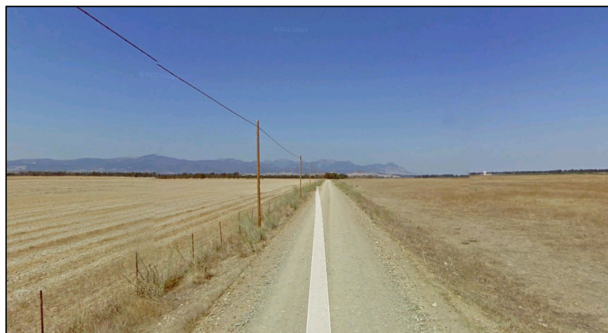
Figura 9: Strada Comunale "Decimoputzu-Villacidro" - Stato Attuale (Preso da Google Earth Street View)
