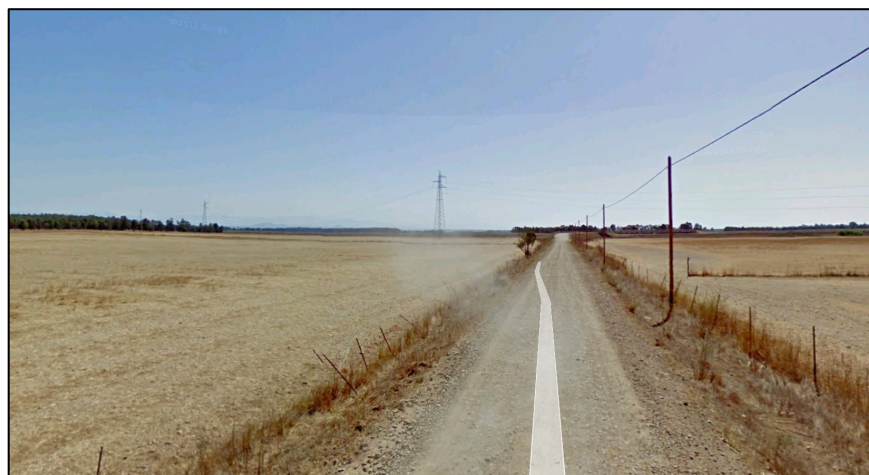
Figura 11: Strada Comunale "Decimoputzu-Villacidro" - Stato Attuale (Preso da Google Earth Street View)
