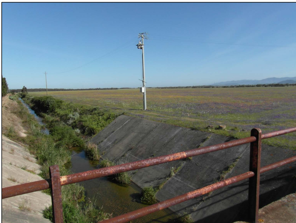
Figura 63: Presa Fotografica dal Ponte su Gora Piscina Longa (Nord Area Impianto)
