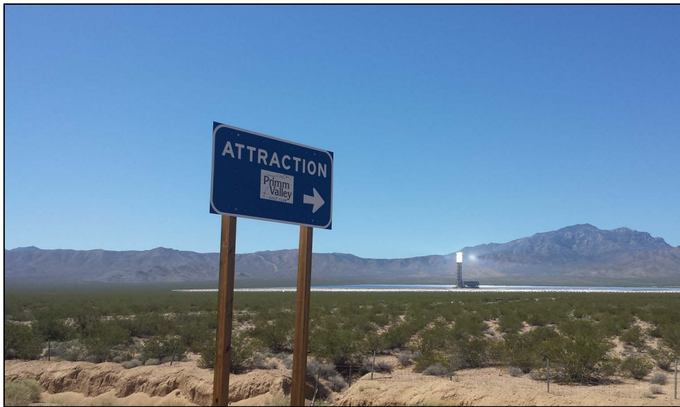
Figura 92: Impianto CSP a torre in California (USA)
