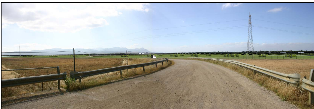
Figura 68: Prese Fotografiche unite dal Ponte su Canale Riu Nou (Est Area Impianto) - Fotoinserimento con opere di mitigazione interne
