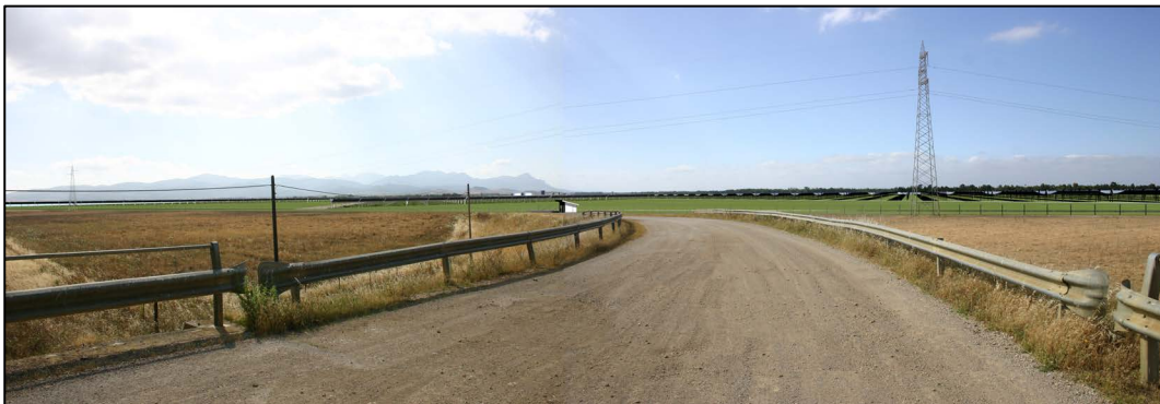
Figura 67: Prese Fotografiche unite dal Ponte su Canale Riu Nou (Est Area Impianto) - Fotoinserimento senza opere di mitigazione
