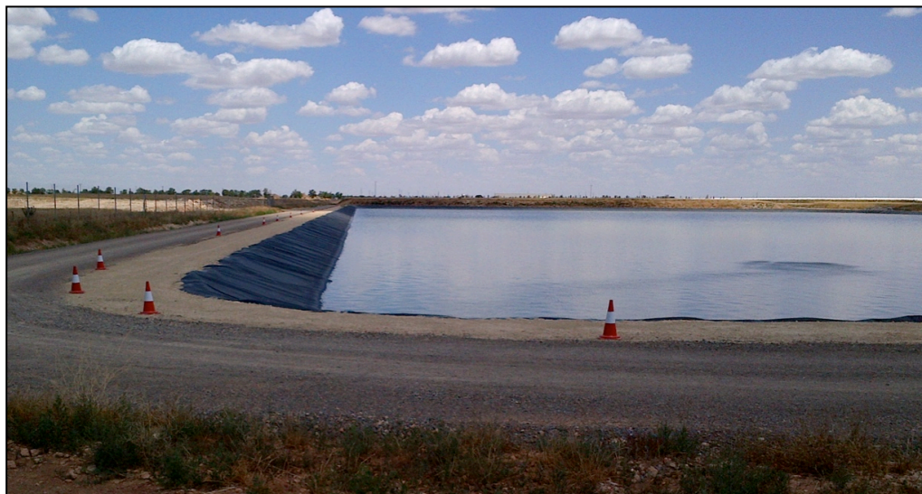
Figura 46: Esempio di evaporation pond in una centrale CSP
