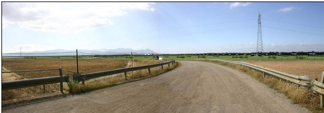
Figura 51: Prese Fotografiche unite dal Ponte su Canale Riu Nou (Est Area Impianto) - Fotoinserimento con opere di mitigazione interne
