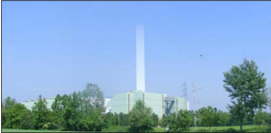
Figura 53: Camino Termovalorizzatore A2A di Brescia - Esempio colorazione strutture elevate
