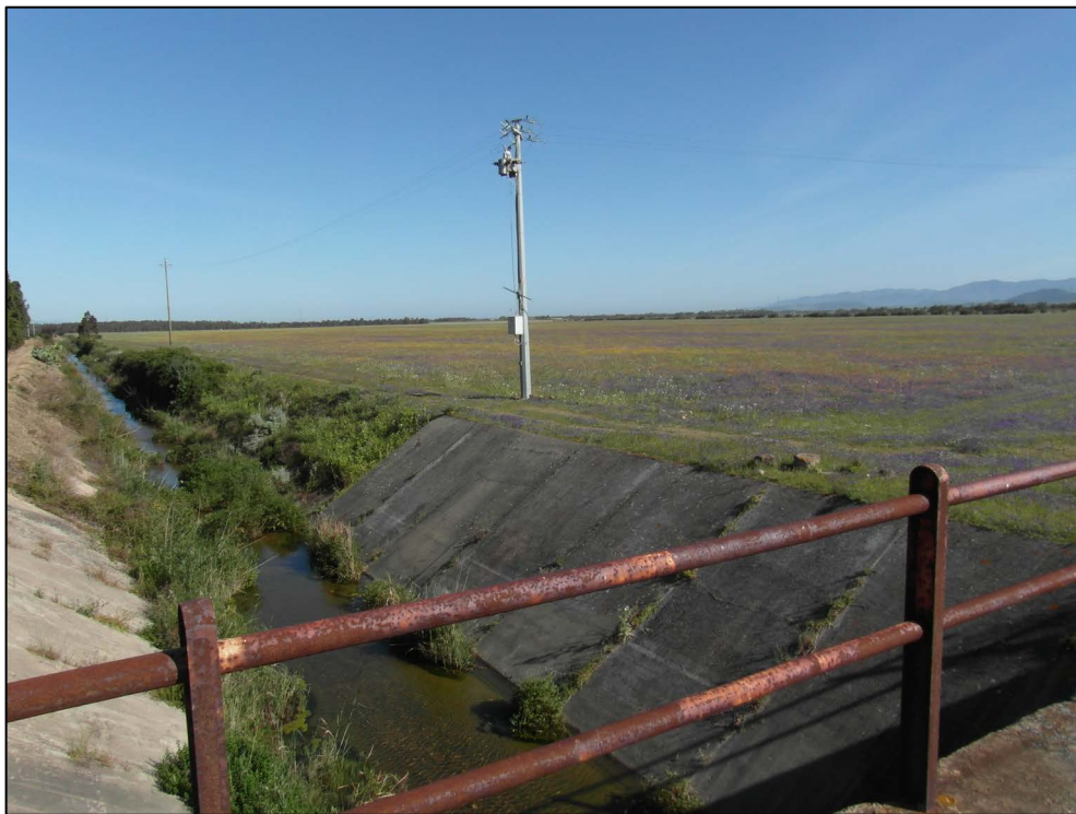
Figura 46: Presa Fotografica dal Ponte su Gora Piscina Longa (Nord Area Impianto)
