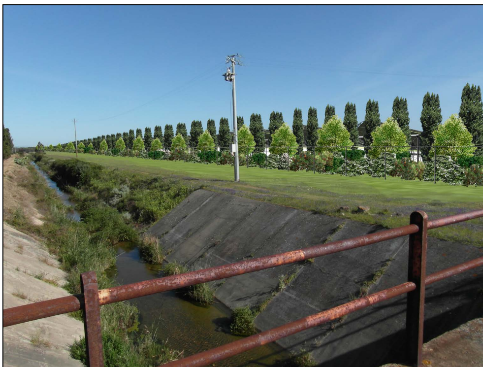
Figura 48: Presa Fotografica dal Ponte su Gora Piscina Longa (Nord Area Impianto) - Fotoinserimento con opere di mitigazione
