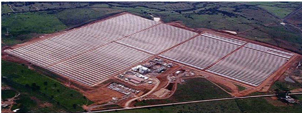
Esempio impianto CSP – Campo Solare
