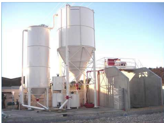
Figure 8.12 Impianti di decantazione acque e disidratazione fanghi
