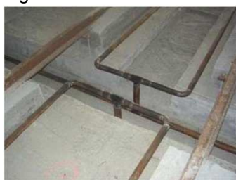
Figure 6.25 Distribuzione del vapore
