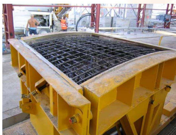
Figure 6.16 Cassero con armatura pronto per il getto
