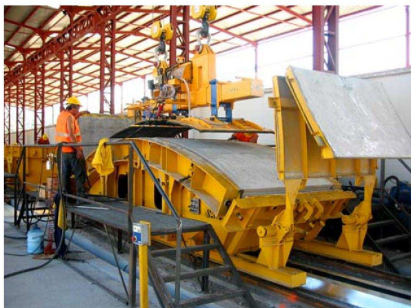
Figure 6.30 Scassero del manufatto
