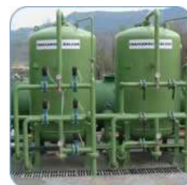
Figure 8.18 Filtri a quarzite/carboni attivi
