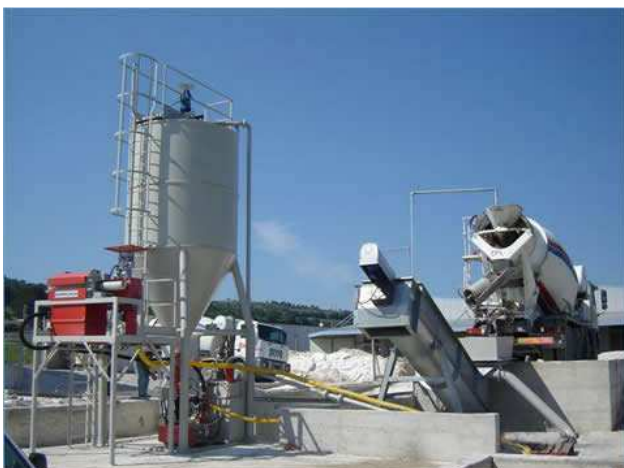
Figure 8.13 Trattamento fango da lavaggio betoniere
