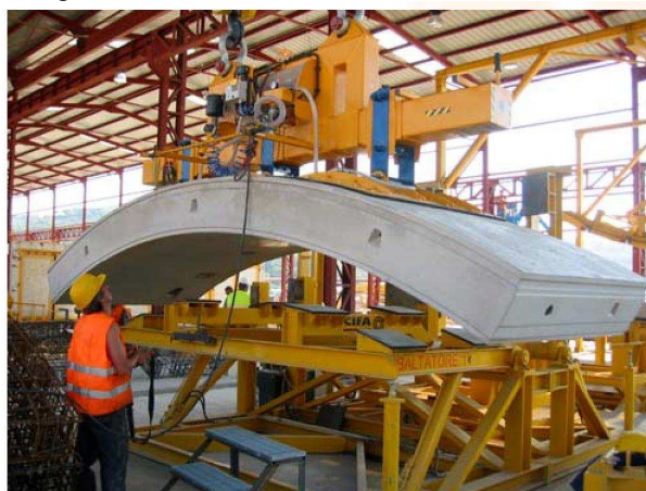
Figure 6.33 Posizionamento del concio sul ribaltatore
