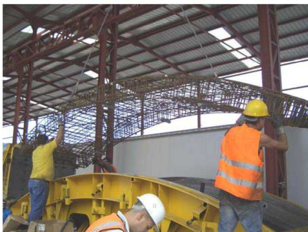
Figure 6.15 Inserimento gabbia di armatura
