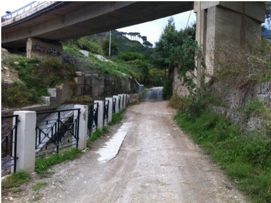
Figura 2.2 Tratto stradale su fondo sterrato
