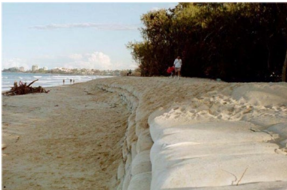
Figura 3.5.37 Esempio di difesa radente realizzata con sacchi di geotessuto (soluzione flessibile) (H. Oumeraci, "Short Course on Shore Protection Strategies")
