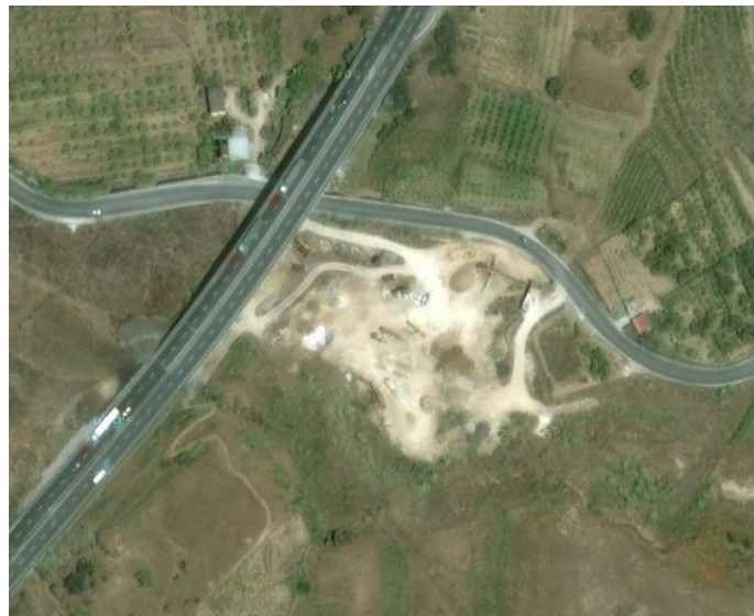
Figura 3.11 Foto aerea con ubicazione cantiere CC1
