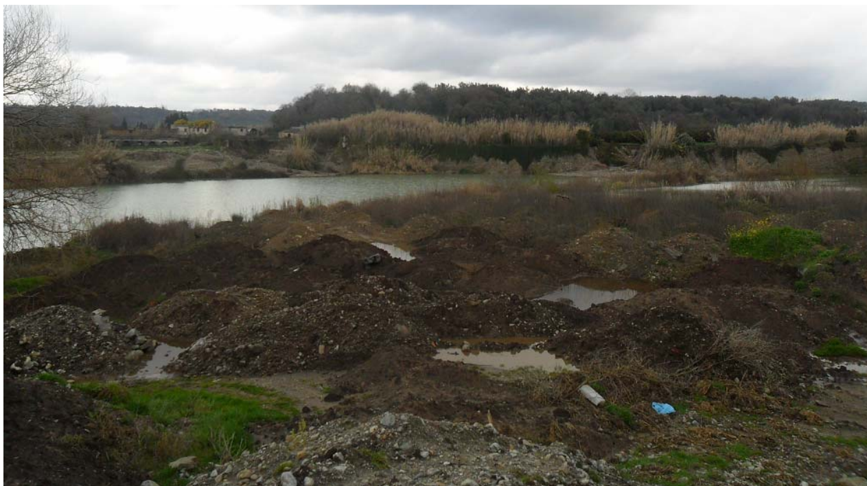
Figura 2.1 – Area di scavo ed intercettazione della falda
