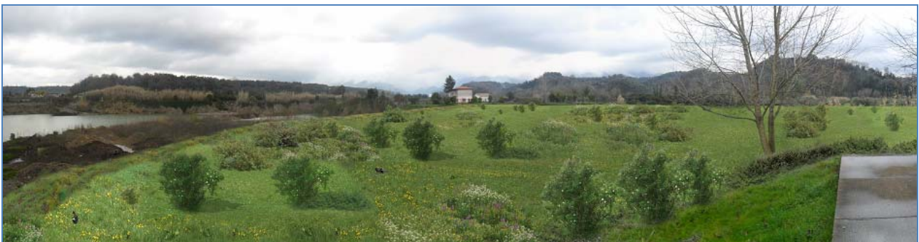
Figura 3.9 – Panoramica direzione S-E sito di deposito CRA 4: situazione post operam deposito definitivo
