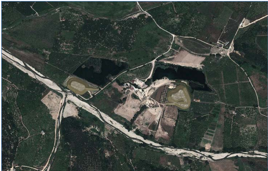
Figura 3.7 – Ortofoto sito di deposito CRA 4: situazione post operam deposito temporaneo
