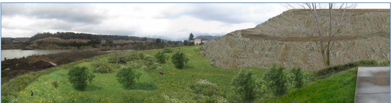
Figura 3.10 – Panoramica direzione S-E sito di deposito CRA 4: situazione ante operam deposito temporaneo
