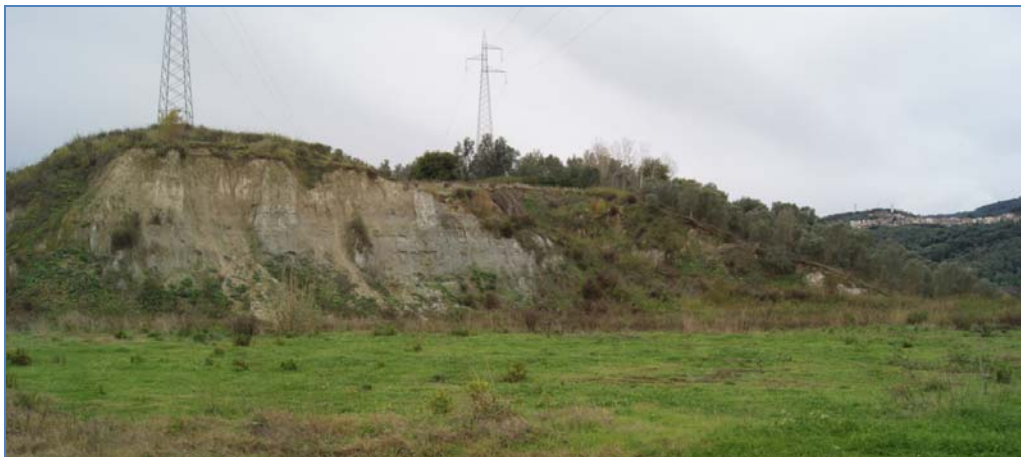
Figura 1.1 – Stato di fatto
