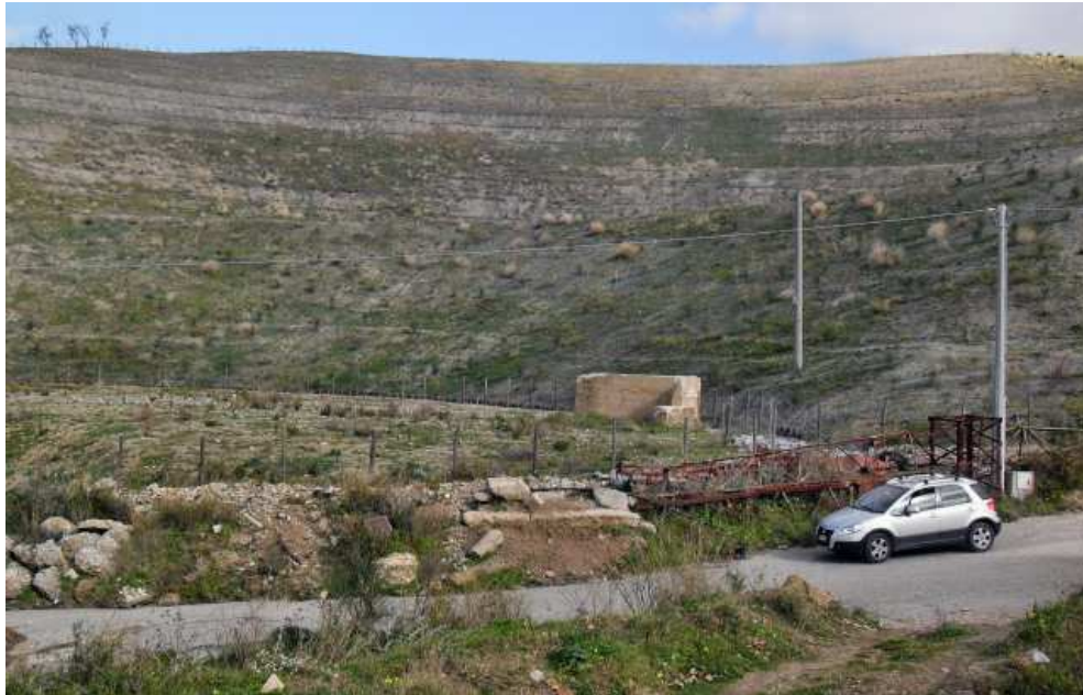
FOTO 2 – Foggia data alla pendice con gradonate ad anfiteatro a seguito della sistemazione finale.
