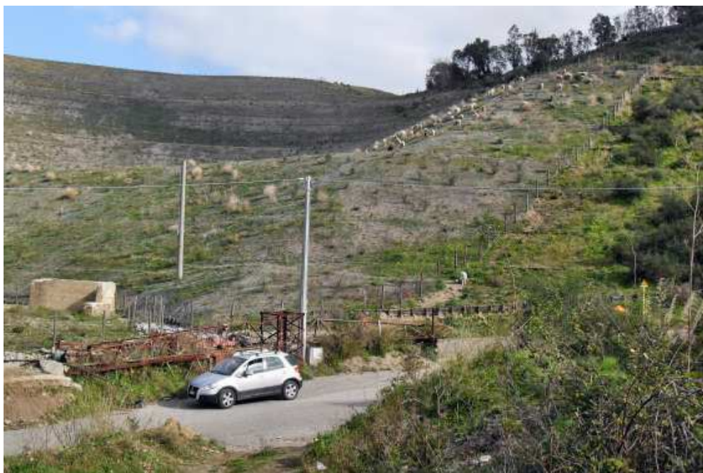
FOTO 2 – Foggia data alla pendice con gradonate ad anfiteatro a seguito della sistemazione finale.
