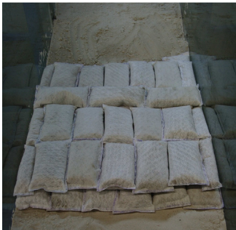
Figura 8.10 Posa del primo strato della struttura.
