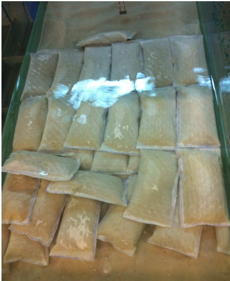
Figura 9.9 Opera di presidio dopo l'esecuzione della prova el_018 (vista dall'alto).
