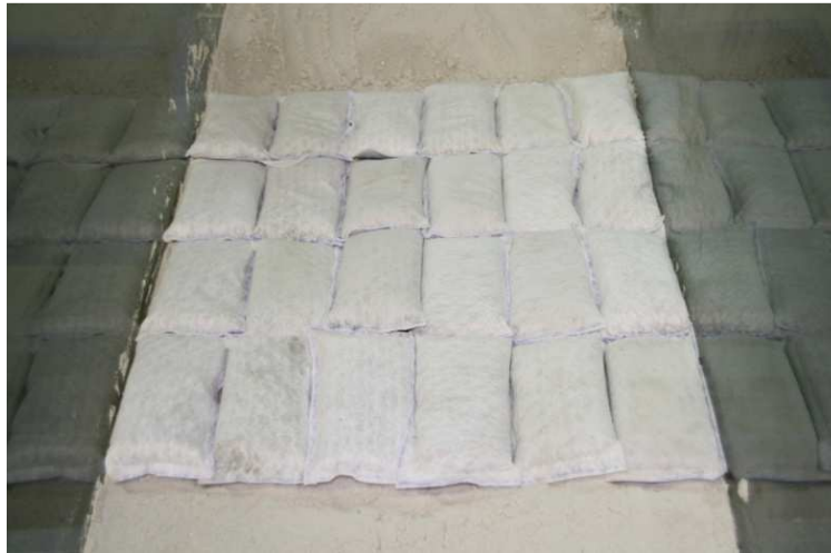
Figura 8.10 Posa del primo strato della struttura.
