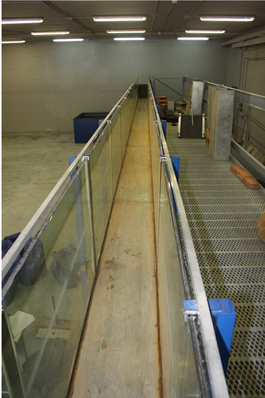
Figura 8.2 Vista del canale prima dell'innalzamento del fondo.
