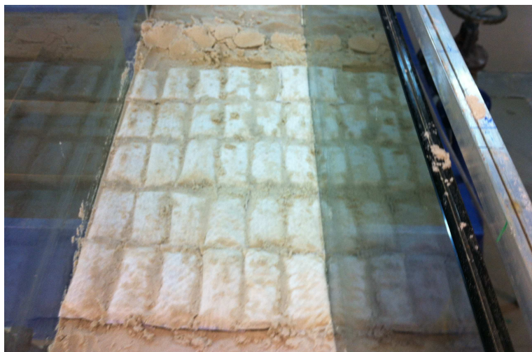
Figura 8.16 Posa del primo strato della struttura modificata.
