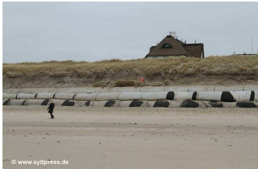
Figura 3.2 Esempio di realizzazione di difesa aderente mediante sacchi in geotessuto: isola di Sylt, Germania (Sylt Press © ).
