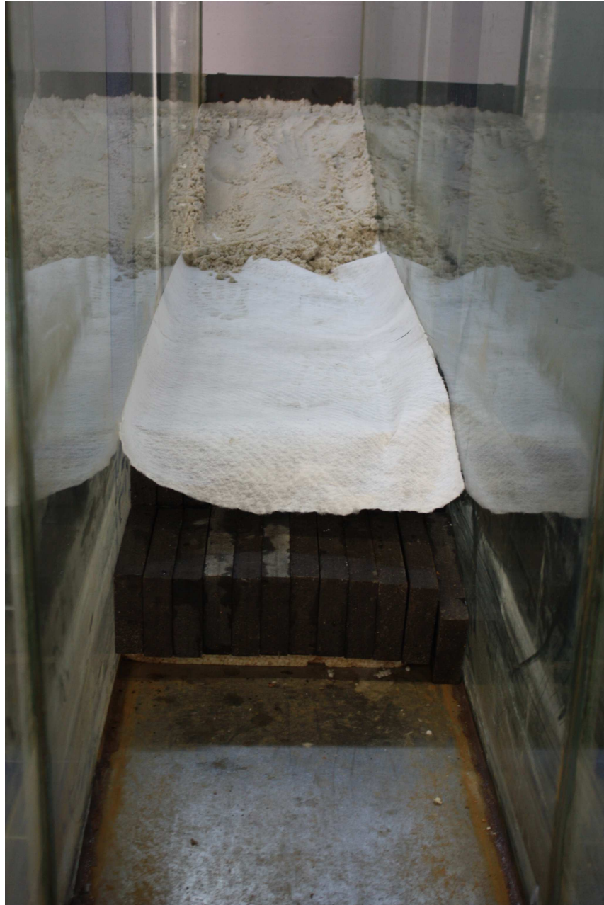
Figura 8.4 Diverse fasi realizzative dell'innalzamento del fondo: disposizione del geotessuto e della sabbia.
