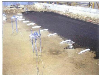
Fotografia 11 Costruzione della scogliera sommersa
