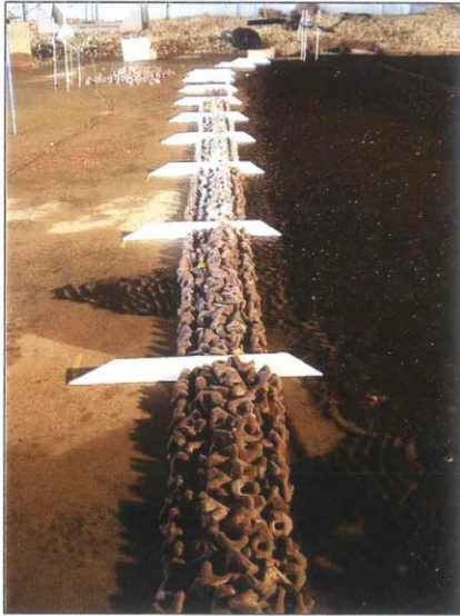
Fotografia 12 Costruzione della scogliera sommersa
