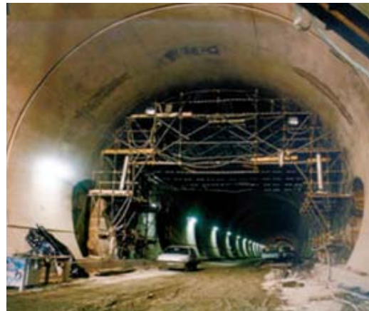
Immagine 13: Rivestimento già realizzato
