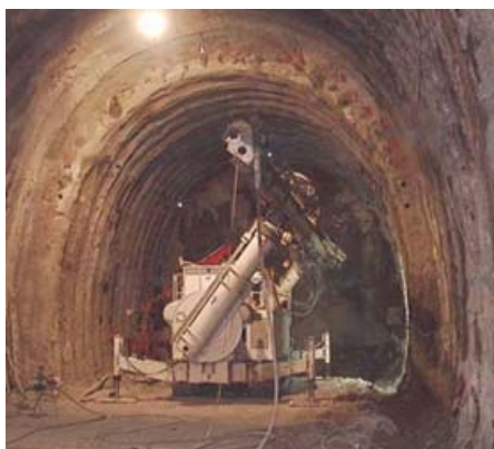
Immagine 3: Consolidamento del fronte mediante fori
