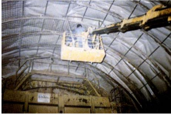
Immagine 11: Uso di cestelli portapersona per armare la calotta
