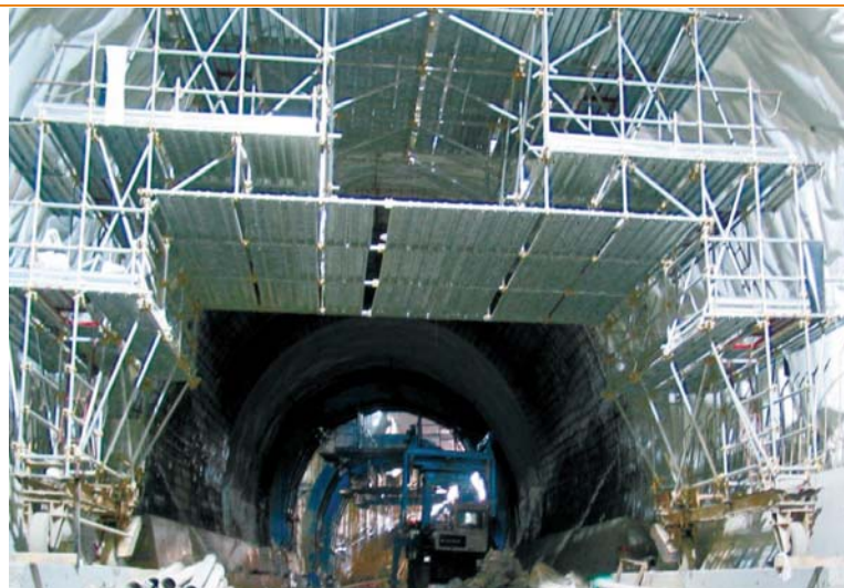
Immagine 10: Ponteggio metallico per il montaggio
