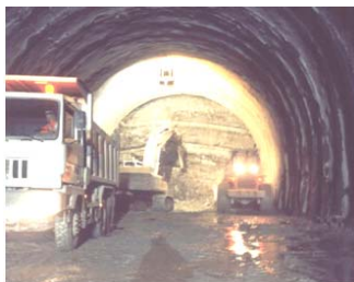
Immagine 4: Scavo di avanzamento con mezzi meccanici
