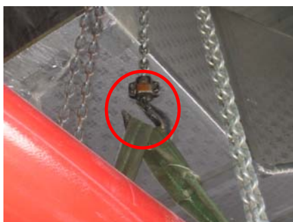
Immagine 5: Assenza gancio di sicurezza
