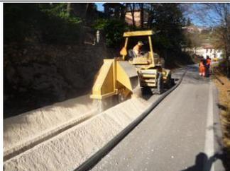
Viene utilizzato per tagli piccoli e scavi a sezione predefinita con elementi di scavo a zappe, per terreno naturale, a denti o misti per scavi su terreno duro e compatto.
